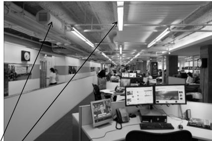
*Integração entre iluminação artificial e ar condicionado*
