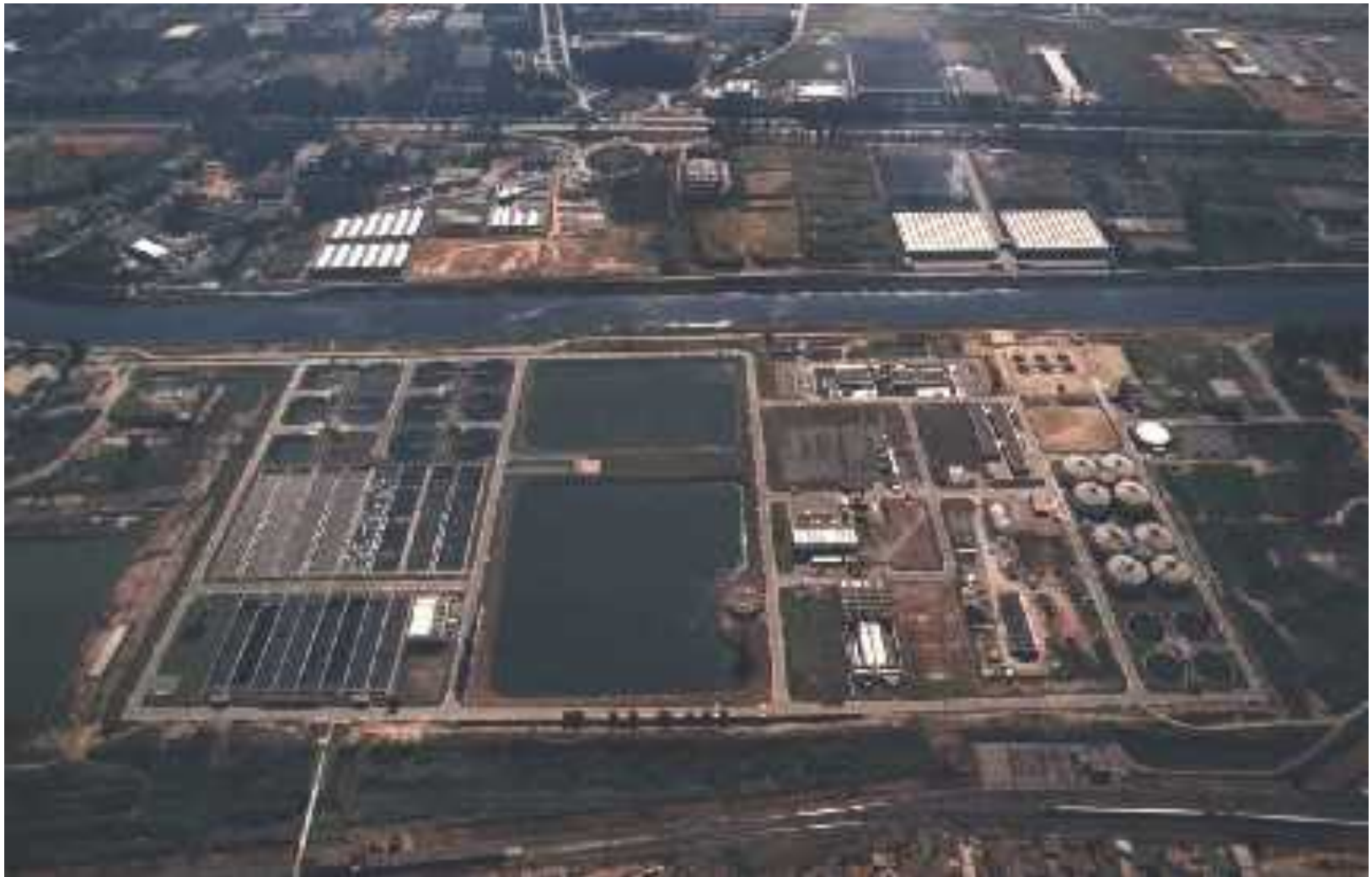
Vista Aérea da Estação de Tratamento de Esgotos de Barueri
