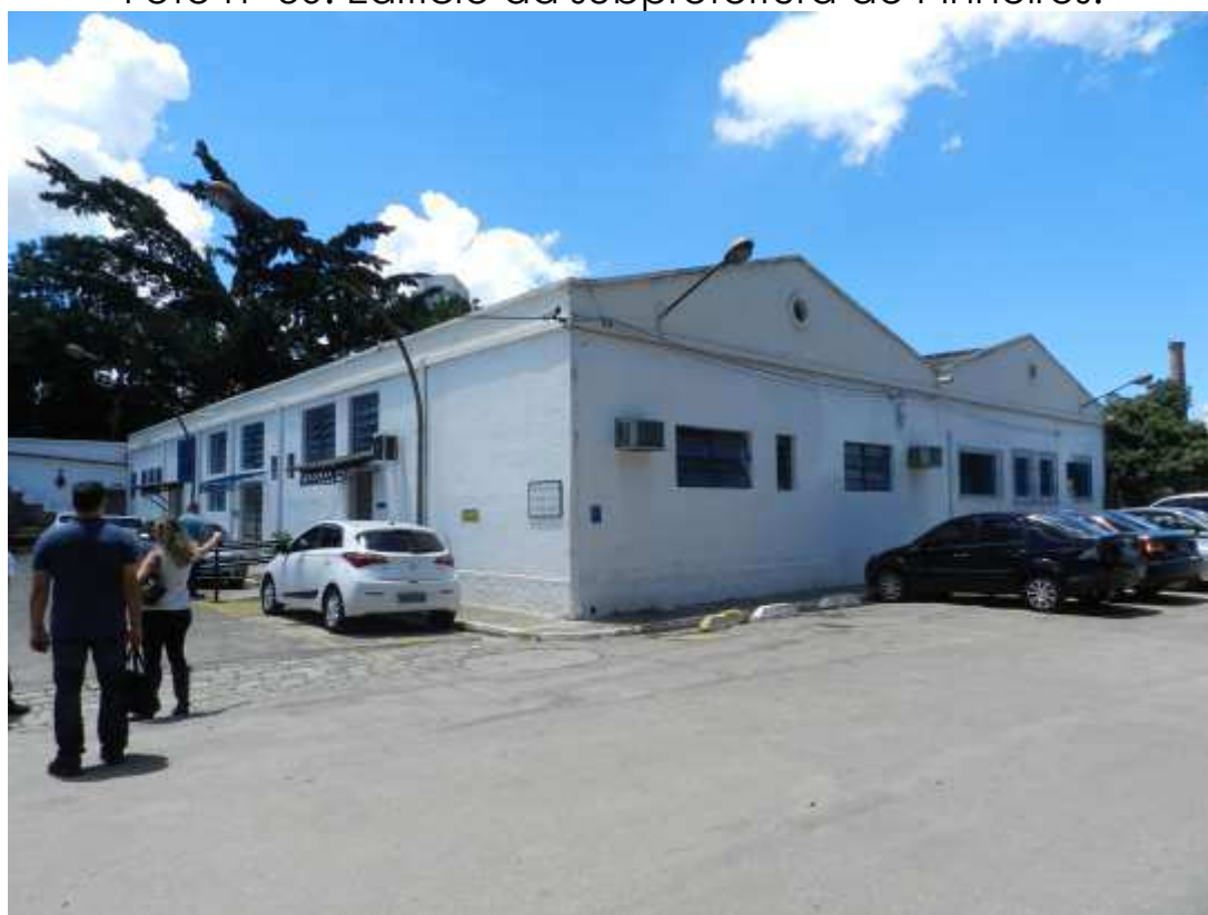
Foto nº 31: edificação existente na área interna utilizada pela CET – Companhia de Engenharia de Tráfego.
