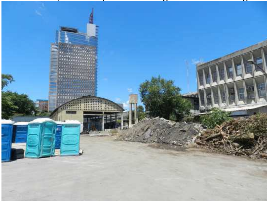
Foto nº 35: outra vista geral da porção interna da área da permuta.
