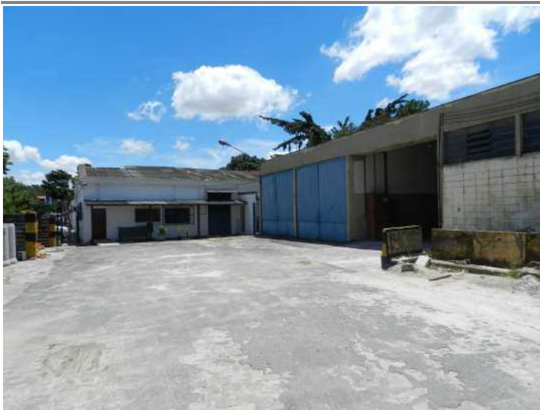
Foto nº 36: área interna e edificação de uso da CET – Companhia de Engenharia de Tráfego.
