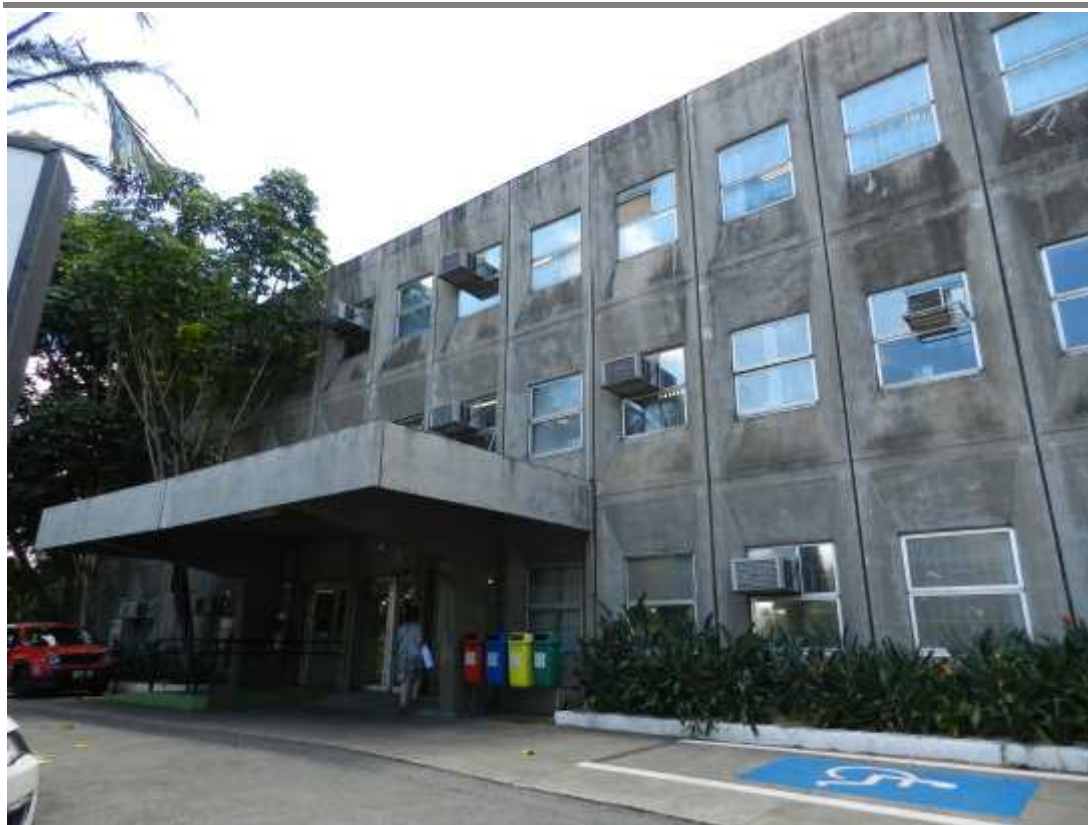
Foto nº 22: Edifício da Subprefeitura Pinheiros na Av. das Nações Unidas.
