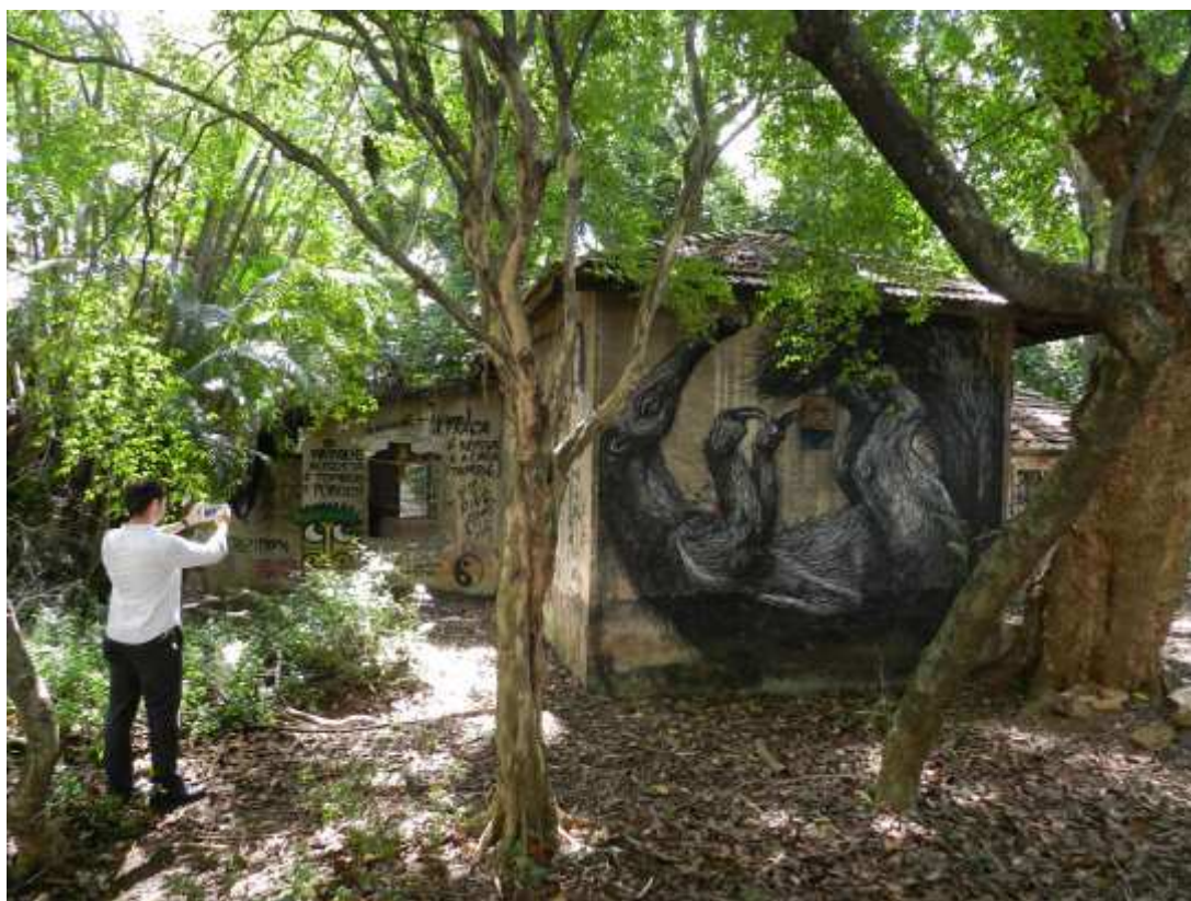
Foto nº 15: outra vista da casa tombada existente no interior do bosque preservado.
