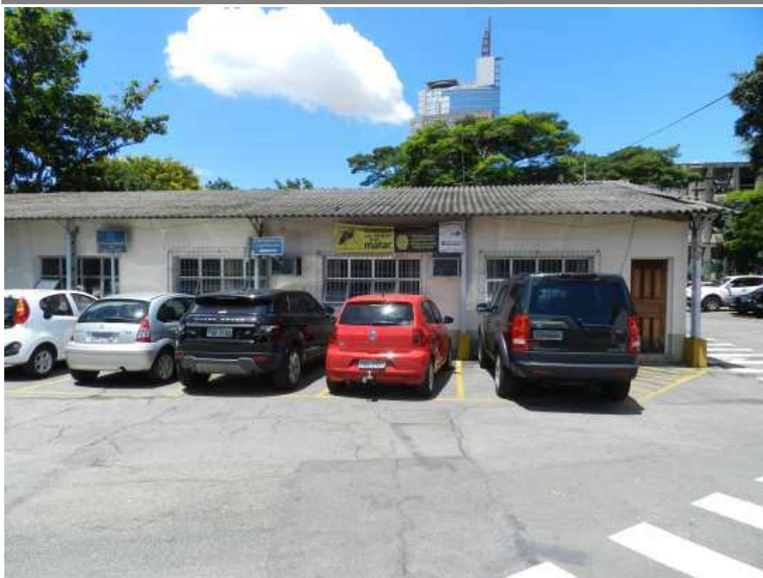
Foto nº 28: Edifício da Subprefeitura de Pinheiros.
