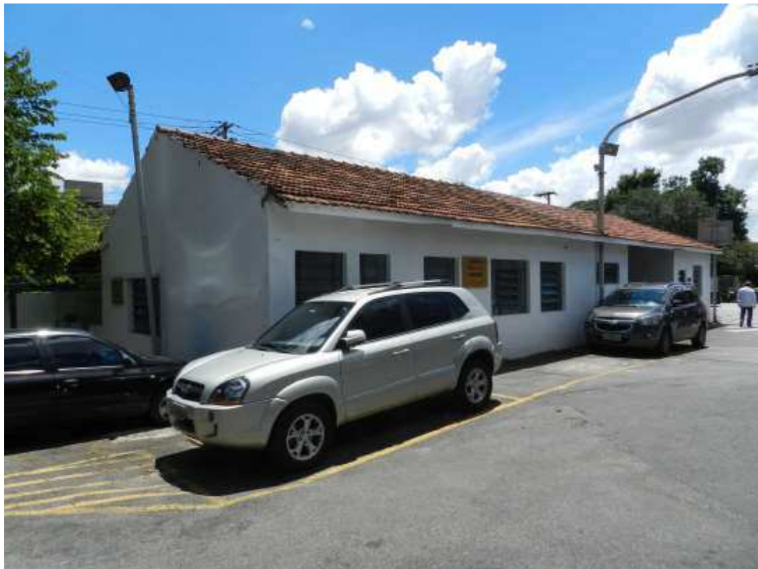
Foto nº 27: edificação da Prefeitura Regional de Pinheiros na área oferecida à permuta.
