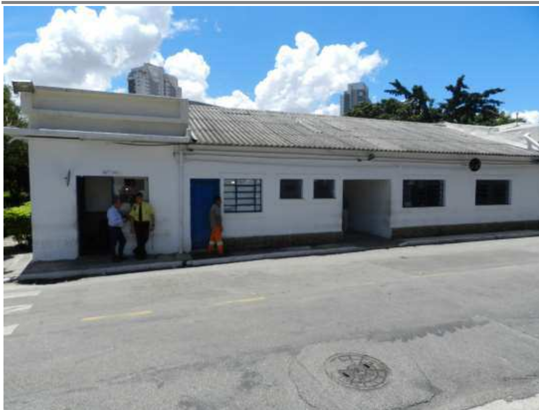
Foto nº 30: Edifício da subprefeitura de Pinheiros.
