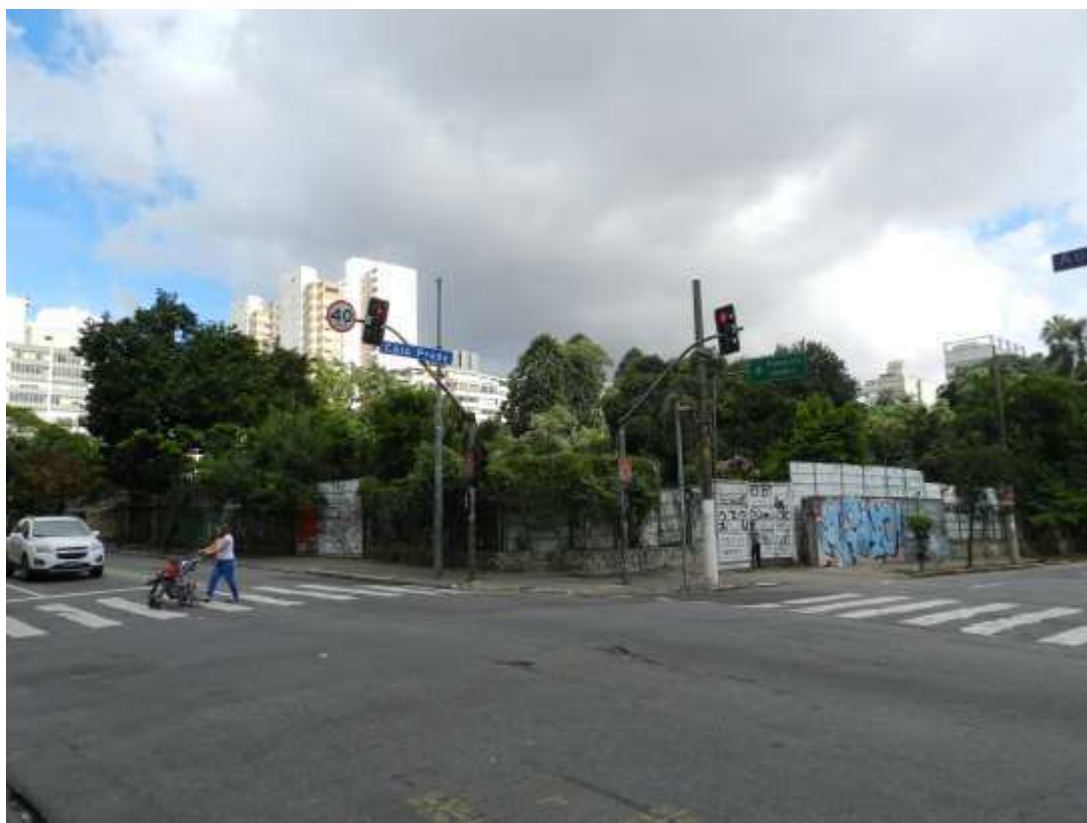
Foto nº 5: imóvel observado a partir da esquina da Rua Augusta com Rua Caio Prado.
