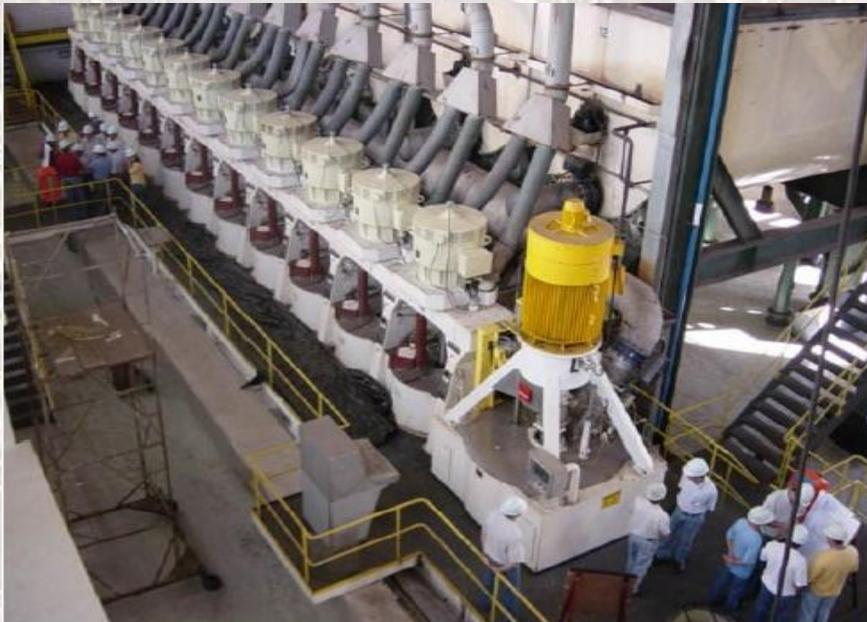
Figura – centrífugas descontinuas ou intermitentes.
