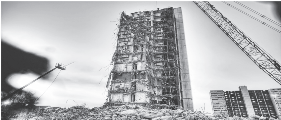
Figura 2: Demolição do Conjunto Cabrini Green, Chicago
