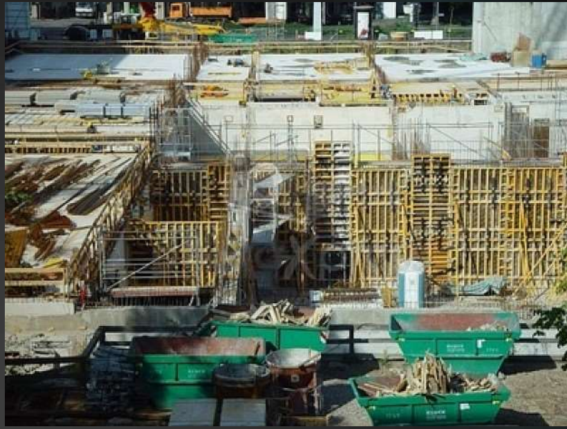
Canteiro de Obra
