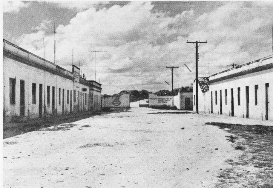
Aspecto da vila operária da antiga fábrica da Passagem, do complexo industrial de Peixoto Gonçalves S.A. (tecidos, cerâmica), no interior de Sergipe, às margens do Rio São Francisco (Foto: Helena França, 1982).
