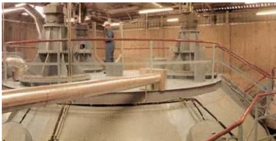
Figura 5 – Vista do topo do reator/digestor WAASA (Fonte: CITEC, 2004)
