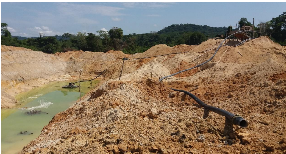
Figura 14 – Transporte de material em polpa por dragagem e sucção em Peixoto de Azevedo (MT)
