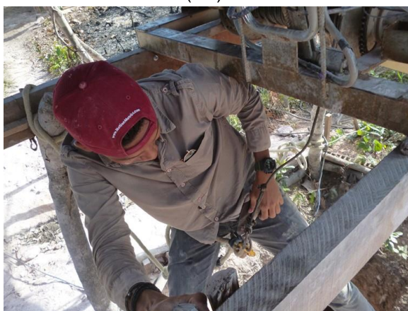
Figura 20 – Guincho para transporte vertical de material e pessoas em Novo Horizonte (BA)
