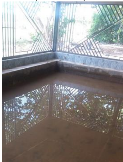
a. Tanque isolado impermeável
