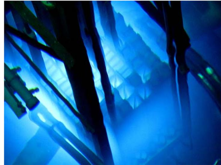
Radiação de Cherenkov (brilho violeta) proveniente do núcleo de um reator nuclear.
