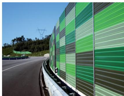
Barreira com painéis metálicos sanduíche: chapas de alumínio com recheio de lã de rocha
