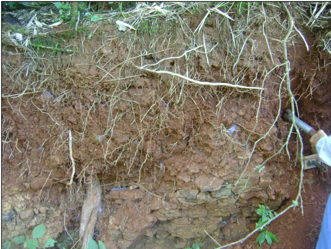
Figura 6.8: Solo Residual da Formação Serra Geral, apresentando estruturas reliquias do basalto (R1SG).
