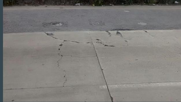
Exemplo de fissuras de retração no pavimento rígido
