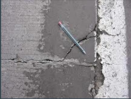
Figura mostrando o esborcinamento, tanto de junta quanto de canto e fissura de canto
