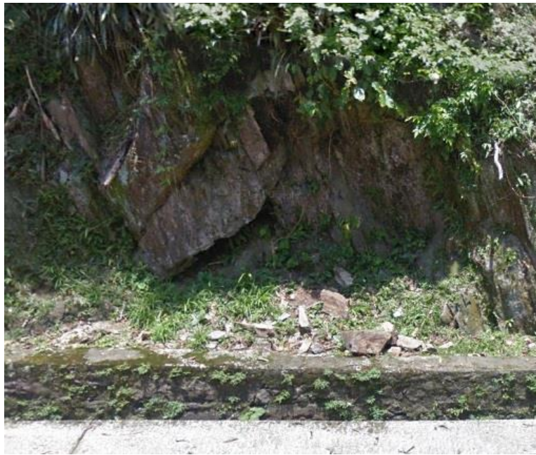
Figura 19: Face Oeste – Pontos com Granito Fraturado e Gnasse com orientação vertical
