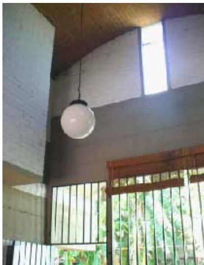
Res. Dalton B. de Toledo - 1961 (arq. Joaquim Guedes). Foto da pesquisadora em visita à casa - dia 30/ 12/ 2002. Vista da sala de estar com pé-direito duplo. Encontro da abóbada com a parede.
