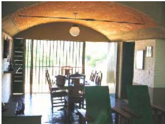
Res. Dalton B. de Toledo - 1961 (arq. Joaquim Guedes). Foto da pesquisadora em visita à casa - dia 30/ 12/ 2002. Vista da copa a partir da sala de estar. Travamento da abóbada é realizado com auxílio de tirantes de aço
