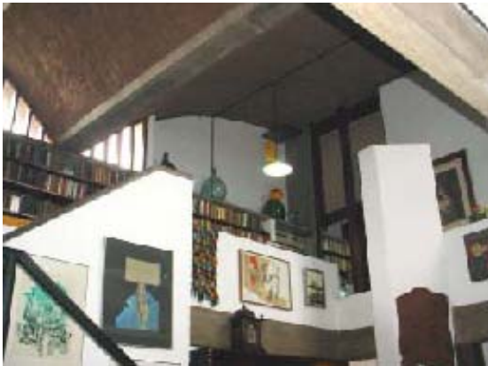
Vista da sala em direção ao mezanino, mostrando a viga central que une as duas coberturas em abóbadas.
