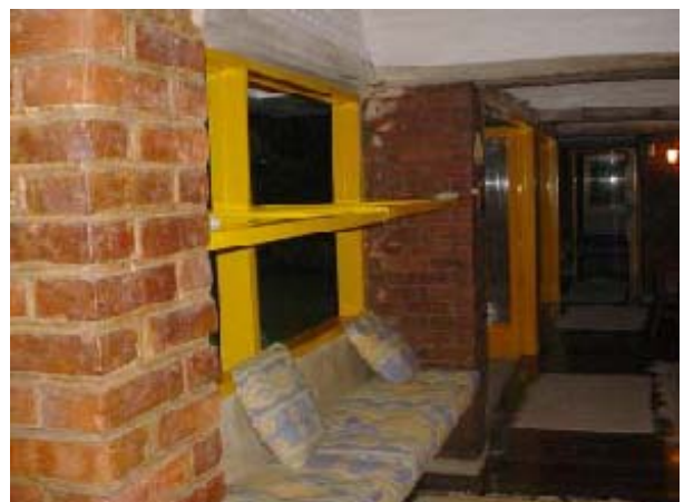
Res. Simon Fausto - 1961 (arq. Flávio Império). Fotos da pesquisadora em visita à casa - dias 19 e 20/ 04/ 2003. Corredor lateral. Janelas pivotantes sobre bancos de alvenaria ao longo de todo o corredor.
