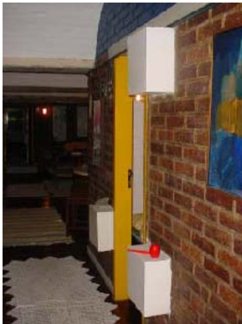
Res. Simon Fausto - 1961 (arq. Flávio Império). Fotos da pesquisadora em visita à casa - dias 19 e 20/ 04/ 2003. Detalhe do corredor lateral. Caixas de cimento encrustadas na parede: funcionam como criados mudos dentro dos quartos e como paradores no corredor
