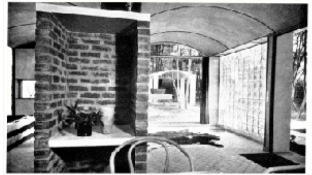
Le Corbusier, Boulogne-sur-Seine (Paris), Casinha para fins de semana, 1935. Fonte: BANHAN, Reyner. “ El Brutalismo em Arqitettura ”, Ed. Gustavo Gilli, Barcelona, Espanha, 1967, p. 95. Detalhe de um aparador executado em alvenaria de tijolos à vista.
