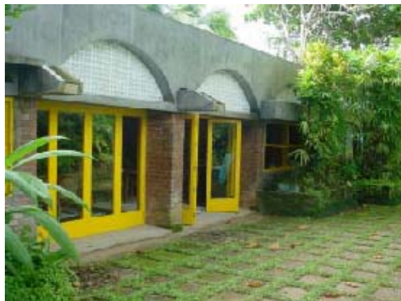
Concreto aparente recentemente recuperado pelo Sr. Gladstone, atual proprietário. Gárgulas conduzem as águas pluviais do terraço jardim para o piso durante o ano inteiro.
