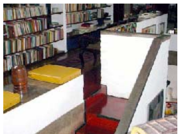
Detalhe do encontro do topo da escada com o banco/ aparador de alvenaria - Foto da pesquisadora em visita à casa - dia 13/ 03/ 2004.
