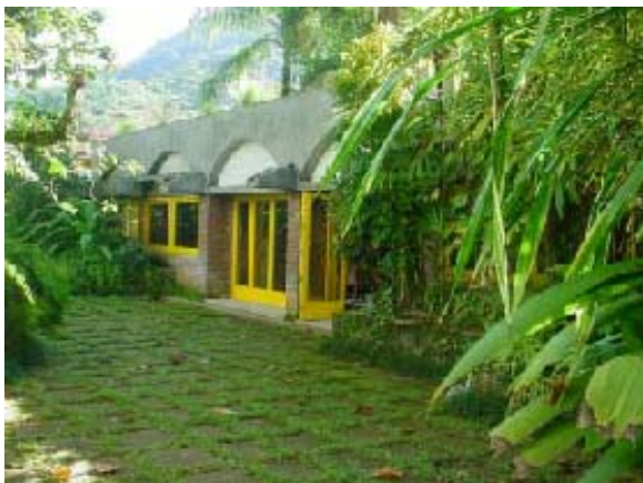
Entrada principal da casa com portas balcão. Amplo e acolhedor jardim na frente protege a intimidade do interior da residência.
