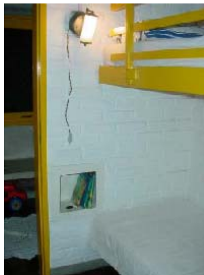
Quarto de hóspedes. Detalhe da caixa de cimento (criado mudo) e luminária.
