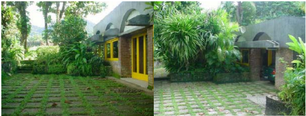
Res. Simon Fausto - 1961 (arq. Flávio Império). Fotos da pesquisadora em visita à casa - dias 19 e 20/ 04/ 2003. Entrada principal da casa com jardim. Paredes externas de tijolo à vista e cobertura em abóbadas com calha e gárgulas de cimento sobre as janelas e portas balcão.
