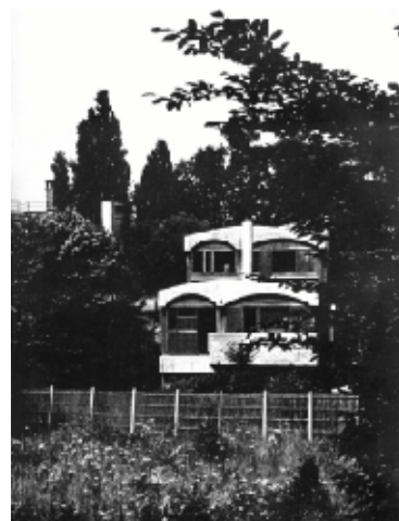
Le Corbusier, Neuilly (Paris), Casas Jaoul (conjunto de casas), 1956. Fonte: BANHAN, Reyner. “ El Brutalismo en Arqitettura ”, Ed. Gustavo Gilli, Barcelona, Espanha, 1967, p. 97. Fachada principal com desenho diferenciado das abóbadas.
