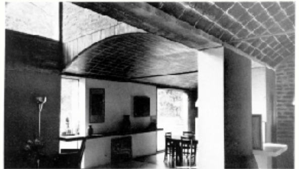
Le Corbusier, Neuilly (Paris), Casas Jaoul (conjunto de casas), 1956. Fonte: BANHAN, Reyner. “ El Brutalismo en Arqitettura ”, Ed. Gustavo Gilli, Barcelona, Espanha, 1967, p. 100. Vista da copa: abóbadas com travamento através de tirantes.
