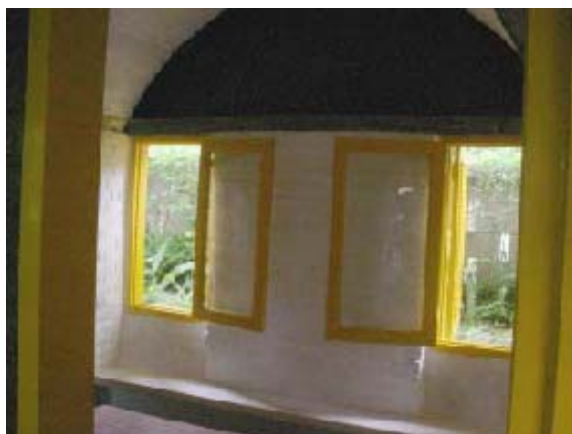
Suíte. Detalhe do banco de alvenaria sob as duas janelas.
