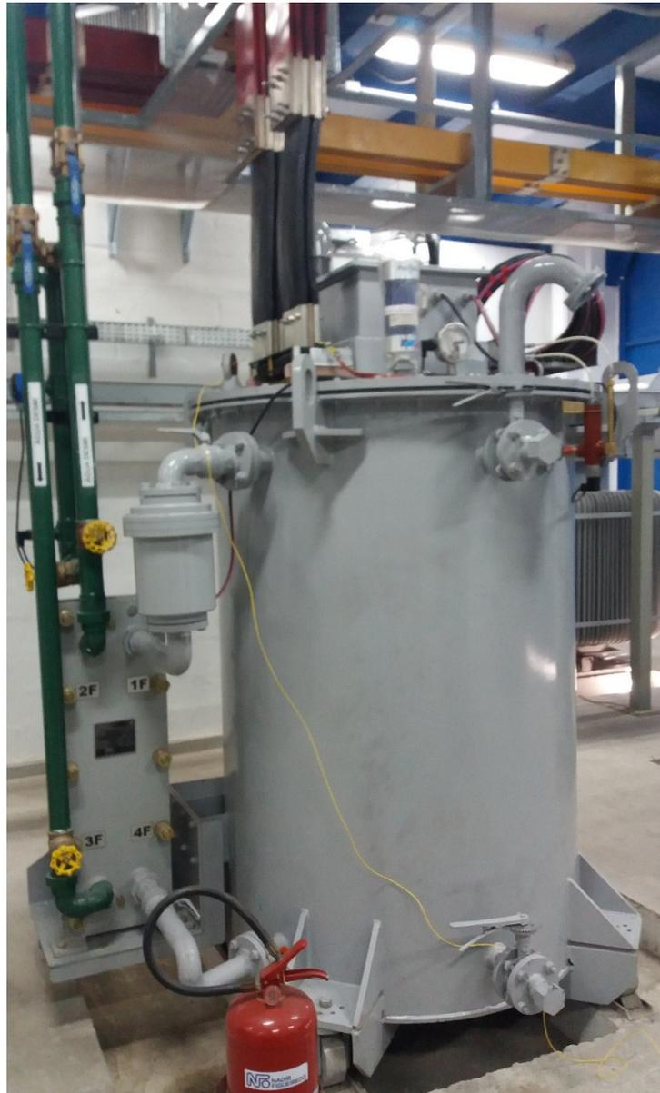
REGULADOR TRIFÁSICO RESFRIADO A AR: 0 / 760V – 1.500 A - 2.000 kVA
