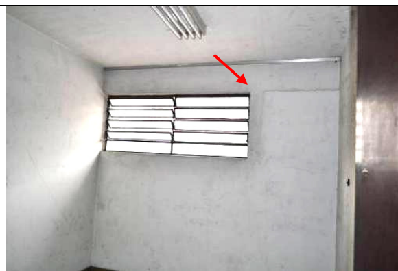
Figura 41 - Imagem interna da sala em que os blocos fecharam a envasadura, com marcas da obra. Foto: Deborah Neves (set/2012)
