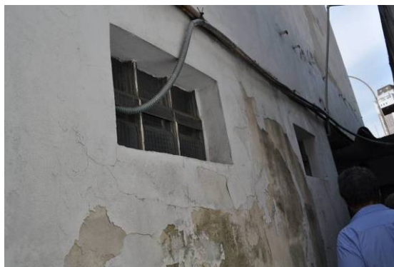
Figura 42 - Janela lateral que ainda possui blocos de vidro, comprovando a utilização deste material no edifício. Foto: Deborah Neves (fev/2013).
