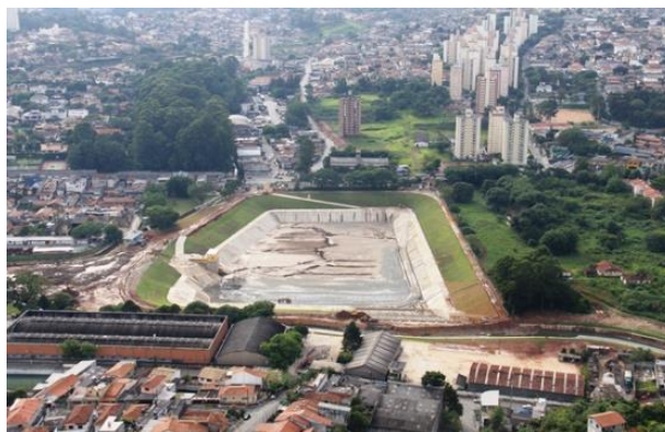
Figura 5. Vista aérea do piscinão da Sharp, localizado na região do Campo Limpo. Fonte: cpienchentes.wordpress.com
