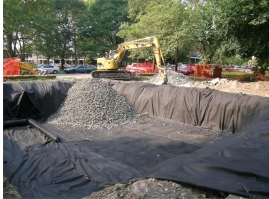
Figura 2-9: Construção de uma trincheira, utilizando uma manta geotêxtil.
