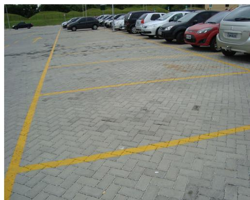
Figura 2-3: Exemplo de execução e pavimento permeável pronto (MOTA; BASTOS, 2013).
