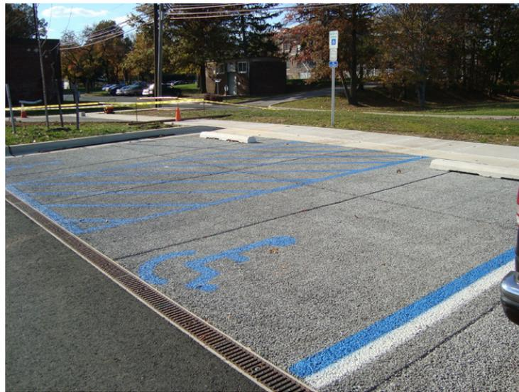
Figura 2-5: Exemplo de pavimento de concreto permeável (MOTA; BASTOS, 2013).
