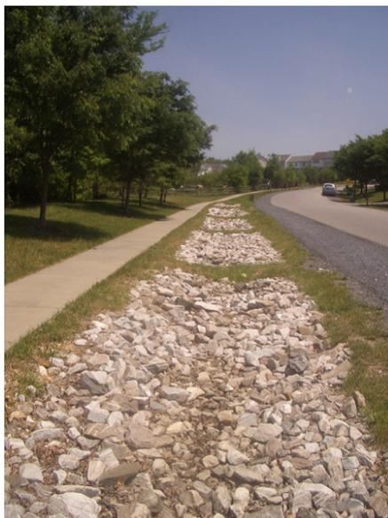
Figura 2-7: Trincheira já implantada, paralela a uma rua.
