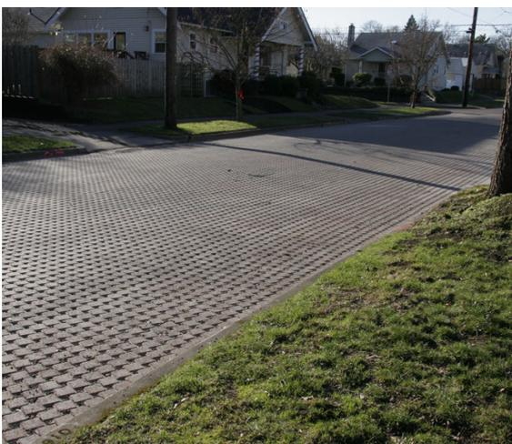
Figura 2-2: Exemplo de aplicação do pavimento permeável (MOTA; BASTOS, 2013).
