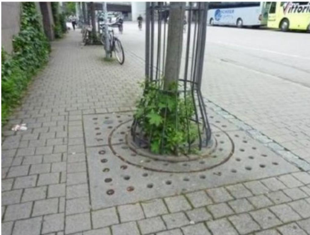
Figura 5 - Uso do piso intertravado em calçadas
