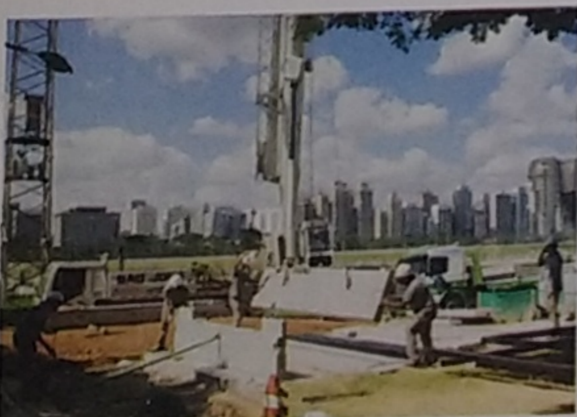
Descida dos painéis de fechamento
