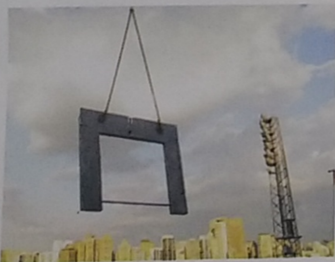
Içamento de painel de porta-balcão
