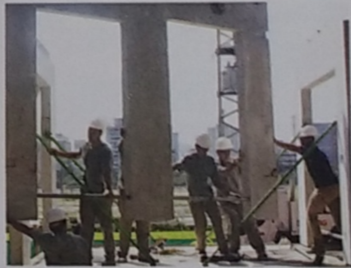
Posicionamento de painel de porta e janela
