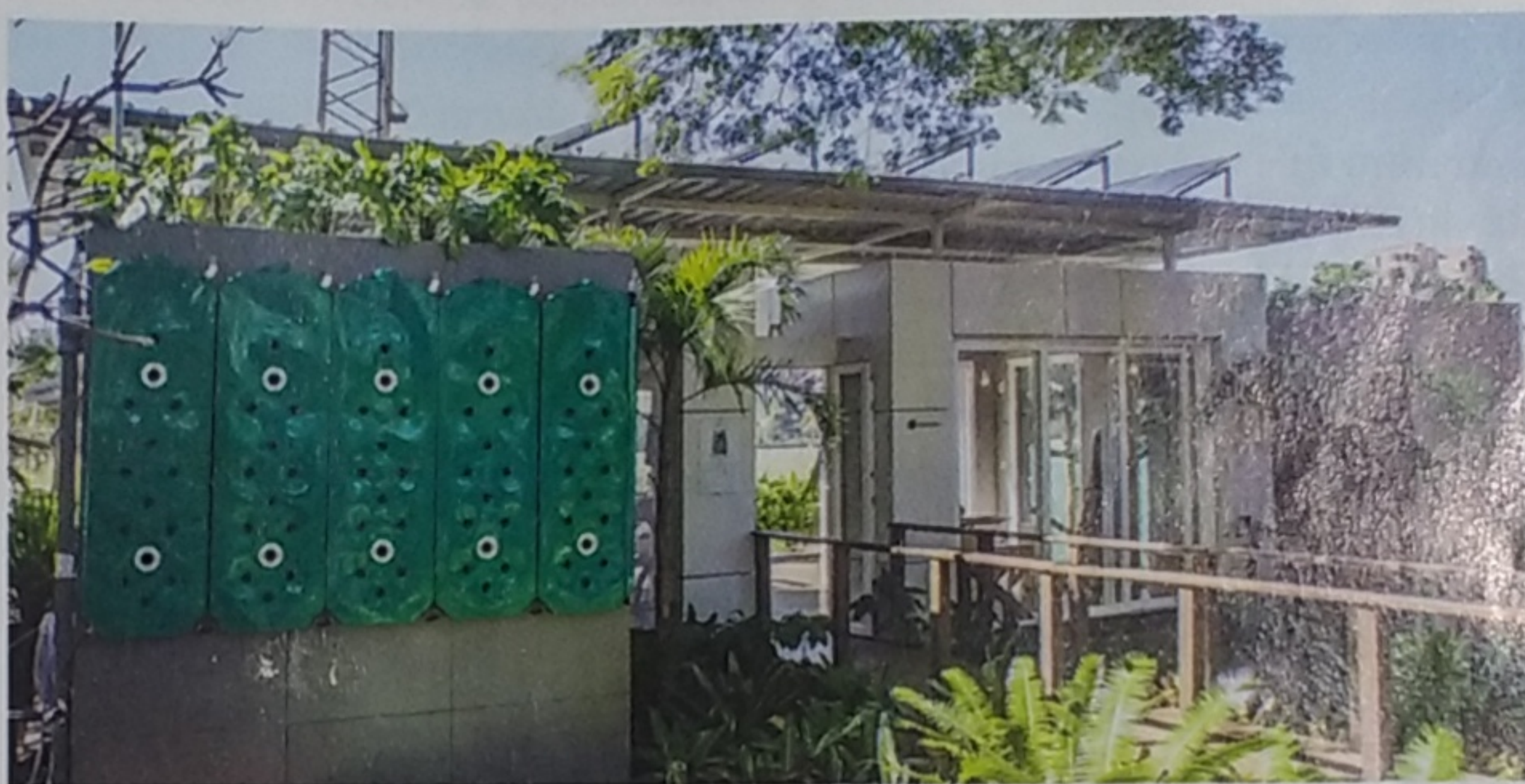
Vista geral da Casa Aqua montada e exposta na Casa Cor 2016, em São Paulo
