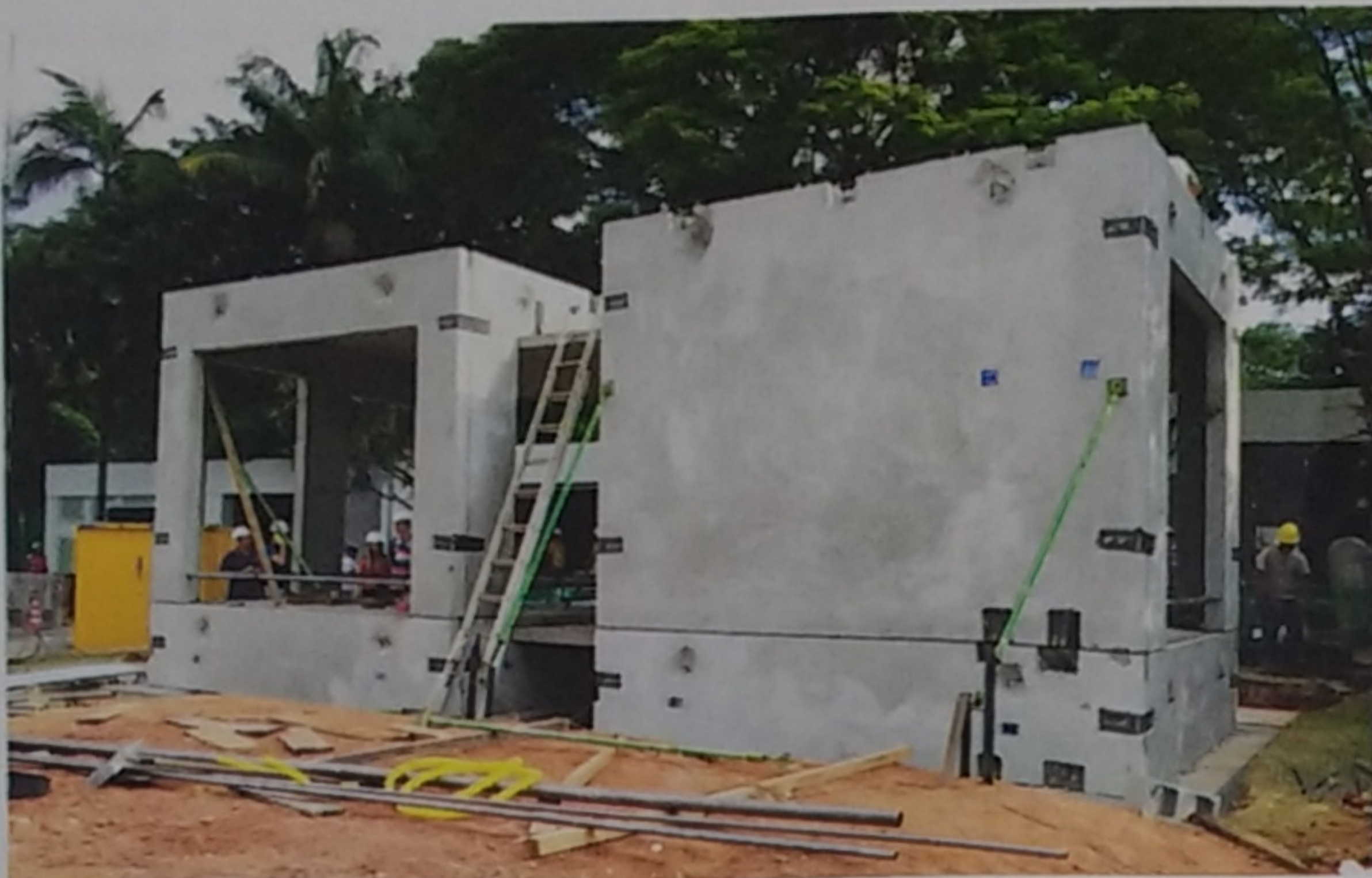
As placas estruturais, embora feitas em concreto maciço, são mais leves devido à incorporação de argila expandida no lugar de pedra britada
