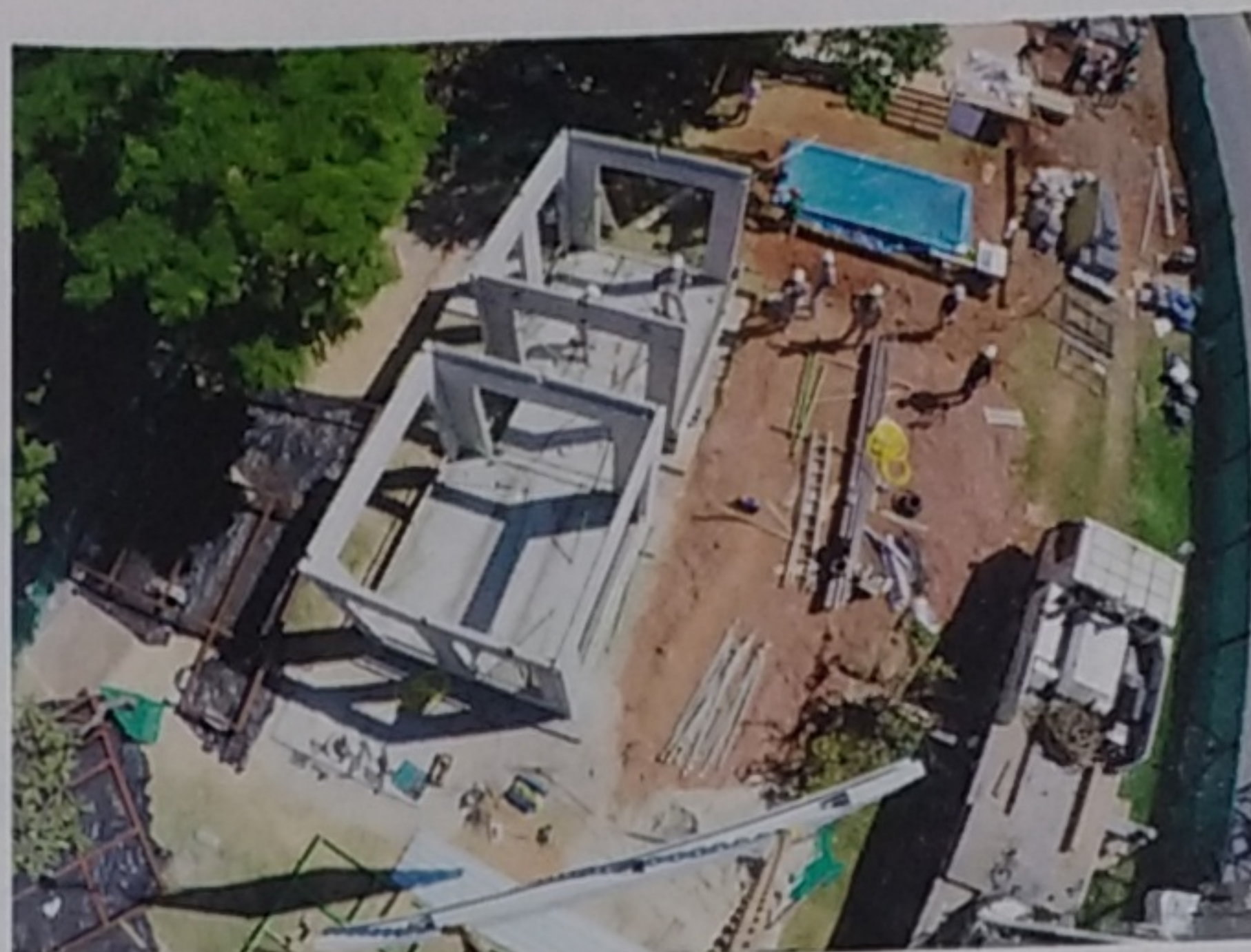
Canteiro transformado em pátio de montagem da unidade
