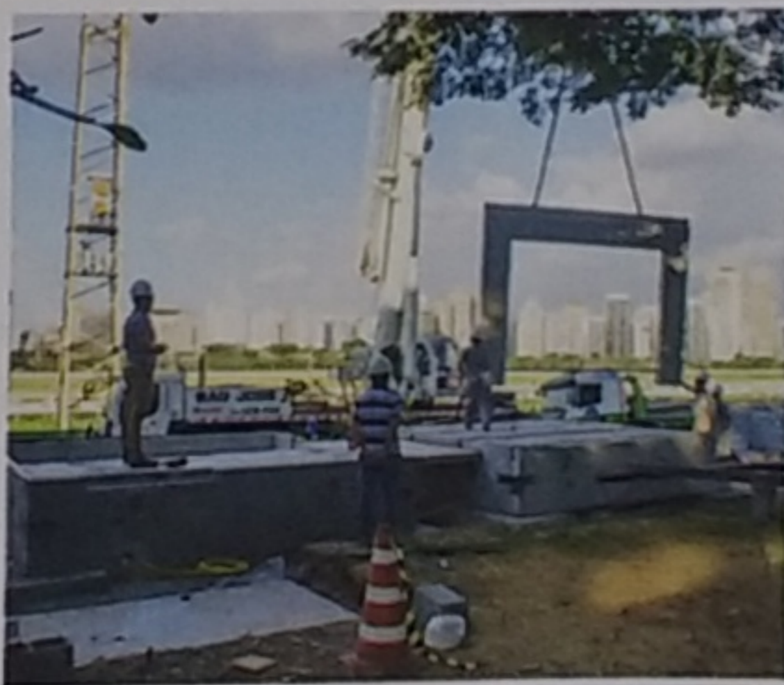
Posicionamento de painel de porta e janela
