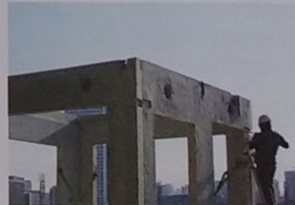
União dos painéis por aparafusamento
