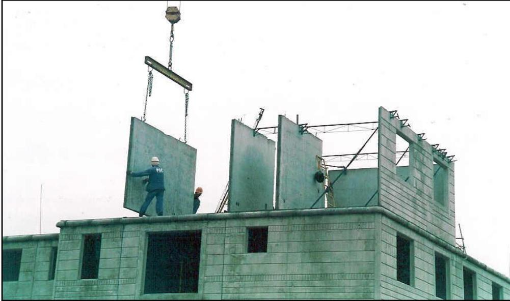
Posicionamento dos painéis com gabaritos de montagem
