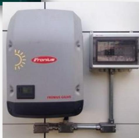
À direita: Medidor e inversor do sistema fotovoltaico.
