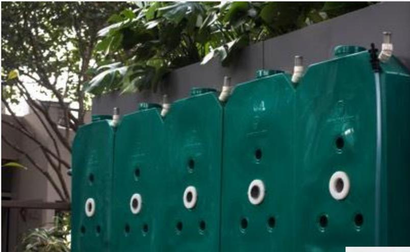
Acima: Cisternas verticais do sistema de captação de água da chuva.
