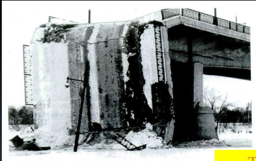
A temperatura de operação deve ser sempre superior à de transição dúctil-frágil → evitar a mudança de comportamento de fratura ,de dúctil para frágil (= *fratura repentina , catastrófica*), durante a operação
