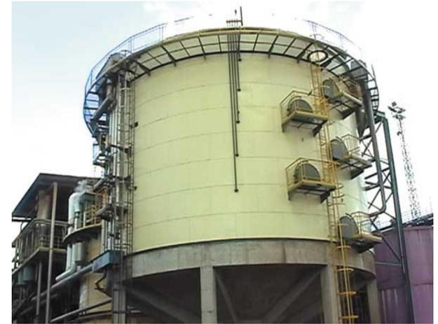
O caldo decantado é retirado da parte superior de cada bandeja e enviado ao setor de evaporação para concentração.
