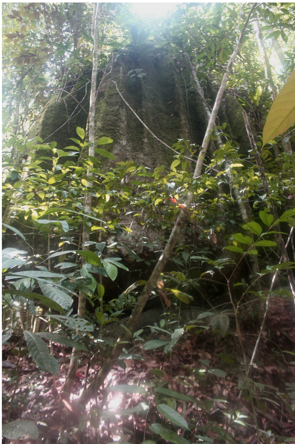
Figura 2. Vista externa da Casa-dos-Animais (foto: Danilo P. Ramos, 2012)
