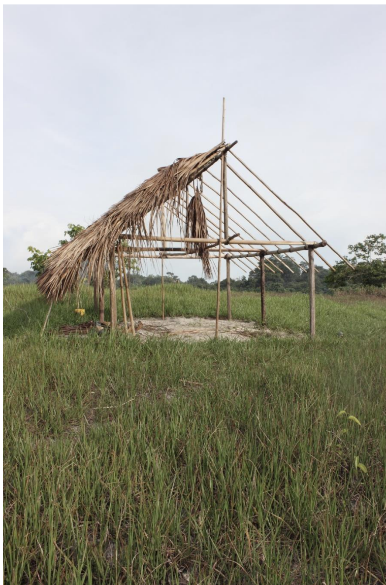
Figura 10. Casa em construção na aldeia de /T̄at-D̄eh/ (foto: Danilo P. Ramos, 2011)
