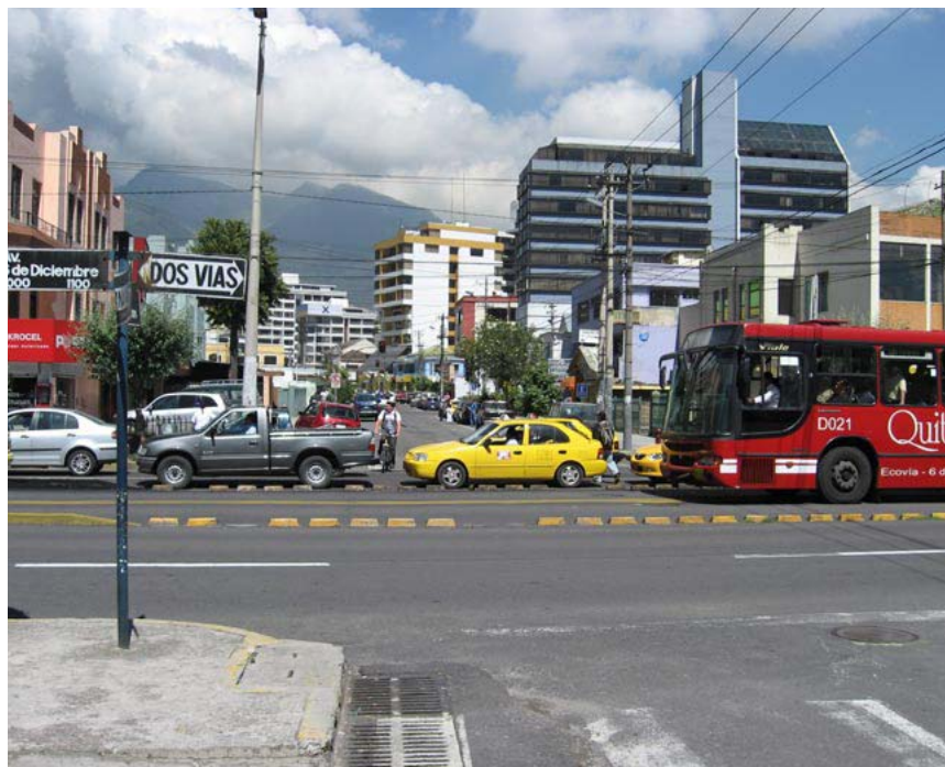
Figura 9.4 Antes da linha Ecovía de Quito, veículos no tráfego misto eram autorizados a cruzar esta interseção bem como negociar conversões à esquerda e à direita. Para dar prioridade ao transporte público, movimentos em frente (na transversal) e a conversão à esquerda (na via) foram bloqueados.
