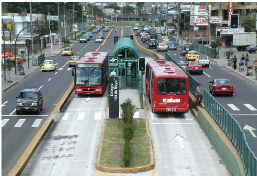
Figura 5.6 O corredor Ecovía em Quito oferece um exemplo de configuração viária de BRT padrão.
