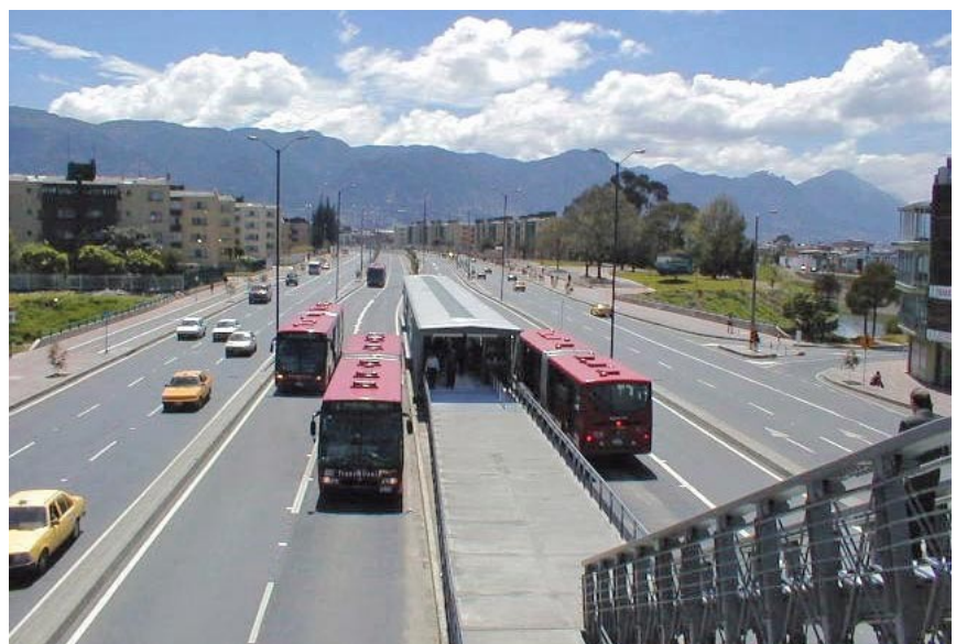
Figura 5.46 Um corredor de ônibus junto ao canteiro central, com uma única estação central se tornou o padrão para sistemas de BRT de alta qualidade.
