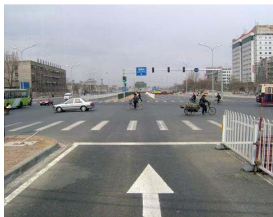
Figura 3.26 O corredor de cinco metros de largura em Beijing era bastante largo para uma única faixa, mas insuficiente para a operação de duas faixas.
