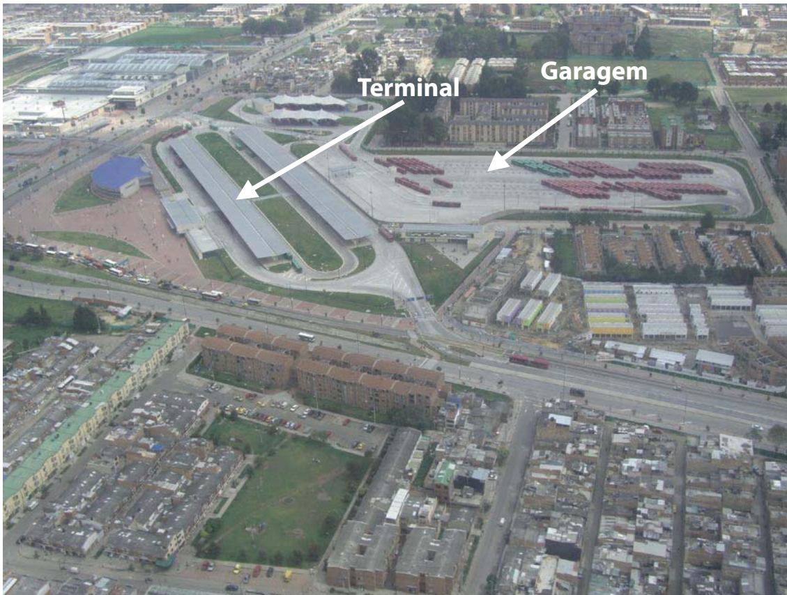
Figura 11.102 Em Bogotá, a maioria das garagens é localizada próxima às áreas terminais de forma a melhorar a eficiência operacional.
