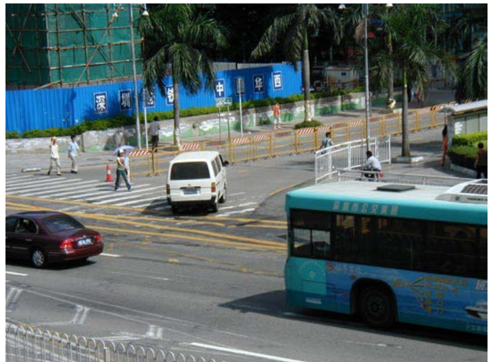
Figura 13.30 Uma grade no meio da rua evita que motoristas abram a curva, em Shenzhen (China).
