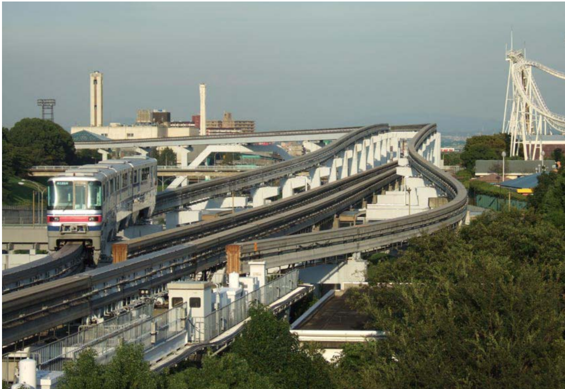
Figura 2.43 Como esta imagem do monotrilho de Osaka mostra, cruzamentos em desnível são usualmente necessários, de forma a permitir a interseção de dois corredores ferroviários com serviços urbanos frequentes.
