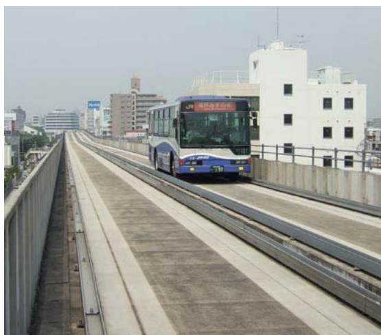
Figura 5.30 A linha Yutorito em Nagoya utiliza estrutura rodoviária elevada para evitar qualquer conflito com tráfego no nível da rua.
