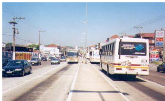
Figuras 8.40 e 8.41 Comboios permitem que o sistema de Porto Alegre atinja capacidades de pico acima de 20.000 pass/(hora * sentido), mas, ao mesmo tempo, essa técnica pode resultar em congestionamento da via e das estações, diminuindo as velocidades médias dos veículos.
