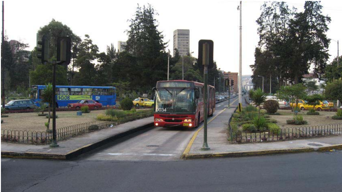
Figura 9.52 A linha Ecovía de Quito corta diretamente através de uma rotatória.
