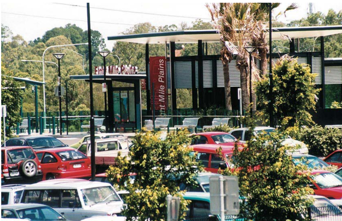
Figura 13.119 O estacionamento na estação Eight Mile Plains do sistema de BRT de Brisbane oferece acesso conveniente aos usuários.
