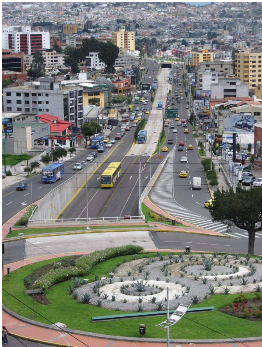
Figura 9.54 A linha Central Norte de Quito, utiliza uma série de passagens subterrâneas para evitar uma rotatória perto da Plaza de las Américas.
