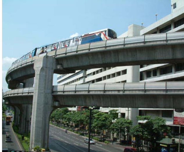
Figuras 2.35 e 2.36 Como a outra metade vive. Condições nos sistemas ferroviários em Bangkok.
