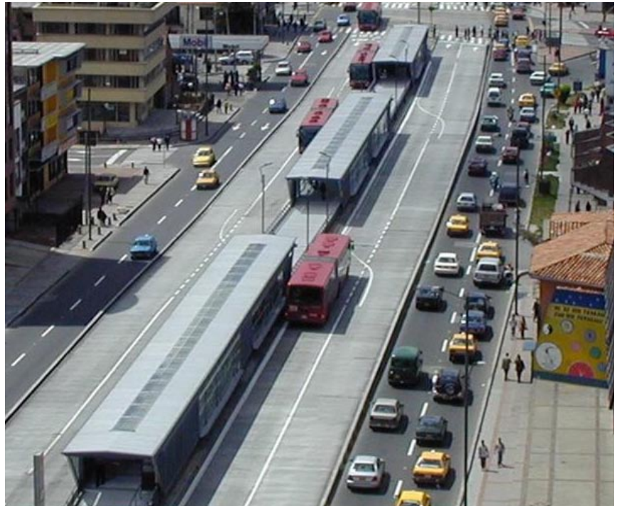
Figura 8.33 O uso de múltiplas posições (baias) de parada é uma das principais razões para Bogotá ser capaz de atingir capacidades muito altas de passageiros.
