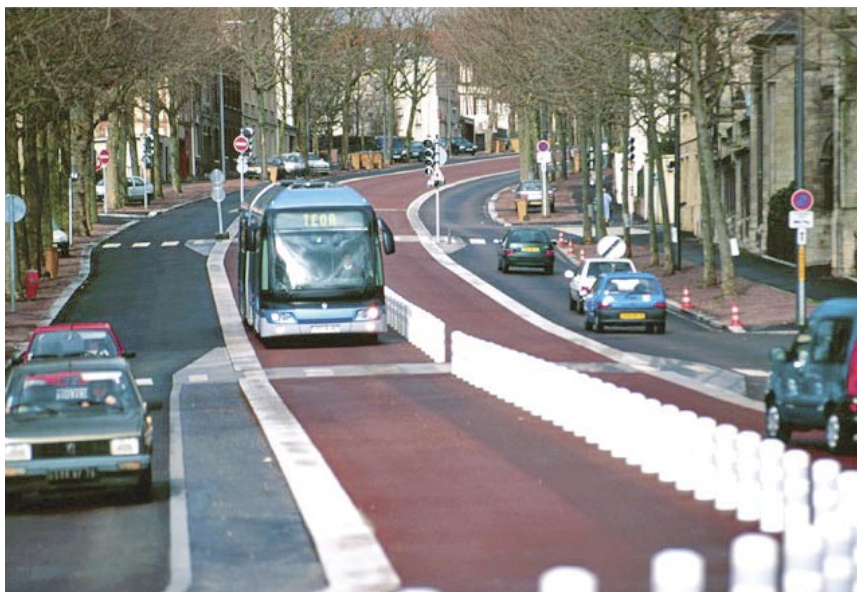
Figura 5.7 Corredores de BRT também podem funcionar adequadamente com apenas uma faixa de tráfego misto, como mostrado neste exemplo de Rouen (França).
