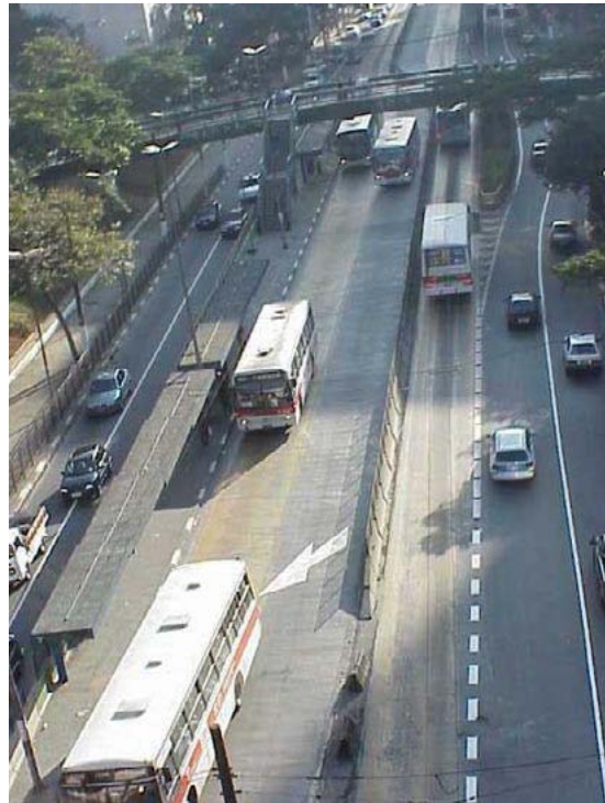
Figuras 7.29 e 7.30 Faixas de ultrapassagem nas estações, como aplicadas em Bogotá (foto esquerda) e São Paulo (foto direita), permitem o oferecimento de serviços expressos e de poucas paradas que resultam em relevantes economias de tempo para os usuários.
