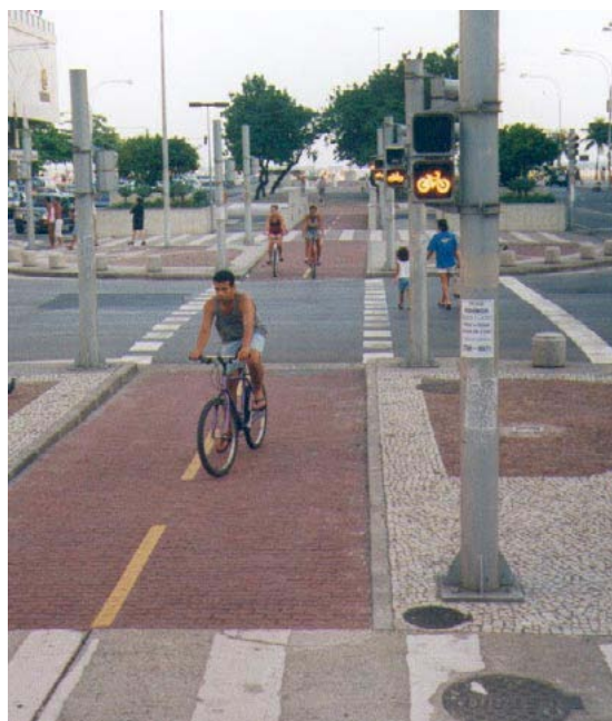
Figura 9.26 Uma fase de verde dedicada à travessia de ciclistas é outra solução eficiente, como mostrado neste exemplo do Rio de Janeiro. Foto por Lloyd Wright
