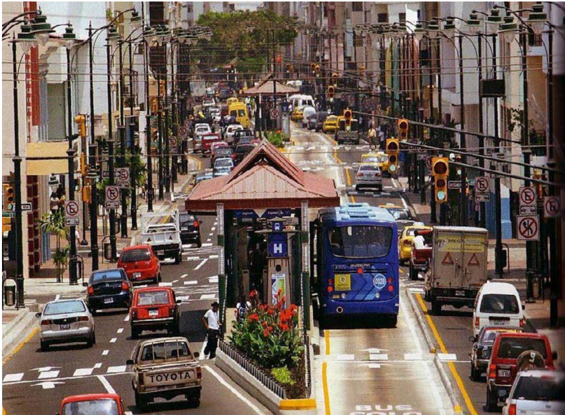
Figura 5.16 Através da área mais densa do centro da cidade, o sistema Metrovía de Guayaquil utiliza uma configuração de corredor dividido com o serviço em cada sentido acontecendo em uma rua paralela diferente.
