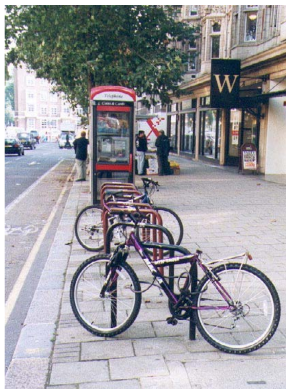
Figura 14.9 Instalações para o estacionamento de bicicletas também podem servir como colunas de separação, impedindo veículos de subirem na calçada, tendo dupla função.
