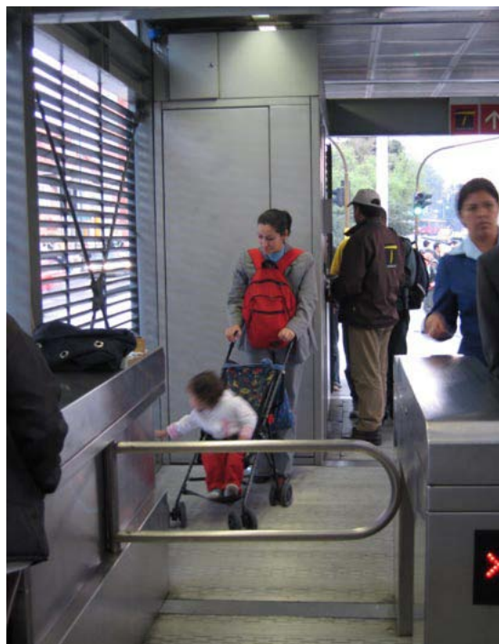
Figura 12.67 Uma opção por catraca de braço móvel é oferecida para usuários com necessidades especiais em muitas estações do TransMilenio.
