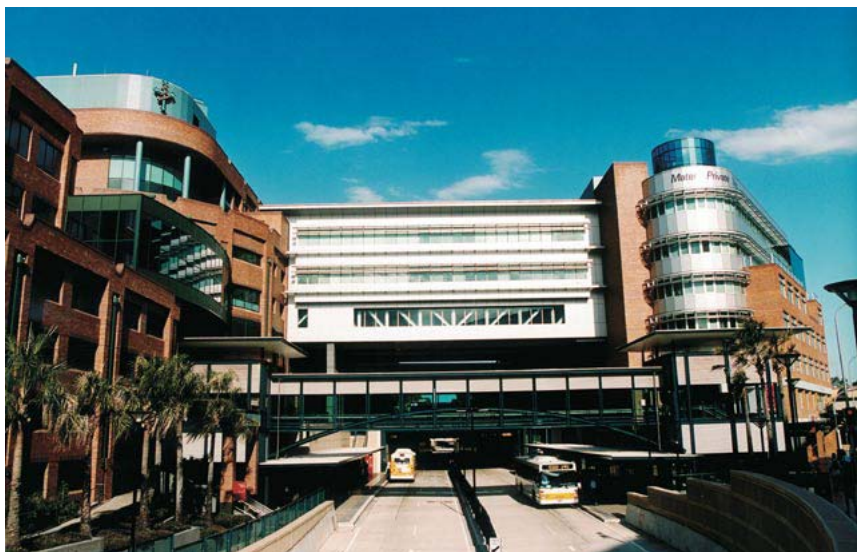
Figura 17.17 O desenvolvimento de um complexo hospitalar sobre a estação Mater Hill em Brisbane gerou receitas de infra-estrutura importantes para o sistema de BRT.
