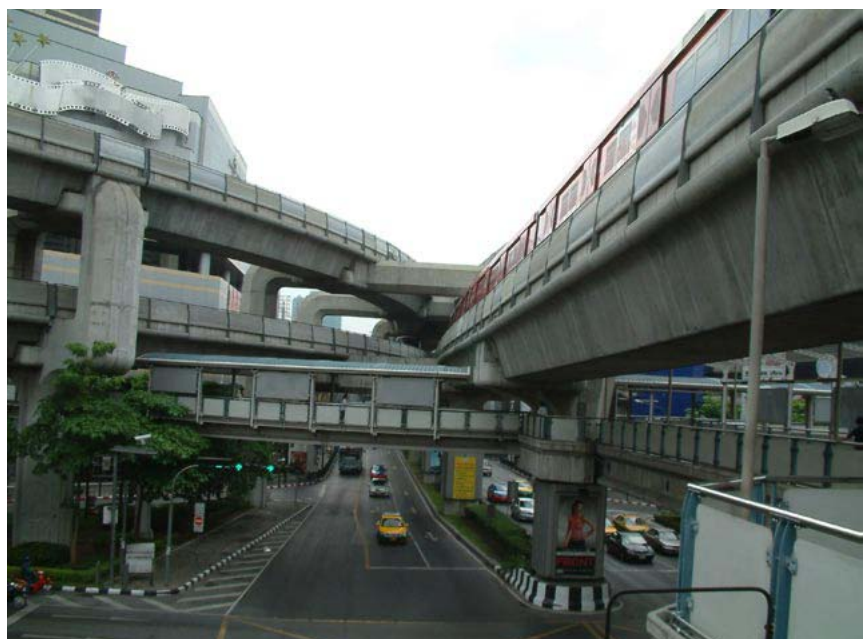
Figura 2.59 Os pilares suportando sistemas elevados, conforme mostrado aqui com o Bangkok SkyTrain, também consomem considerável espaço na superfície, especialmente nos canteiros e, algumas vezes, nas calçadas.
