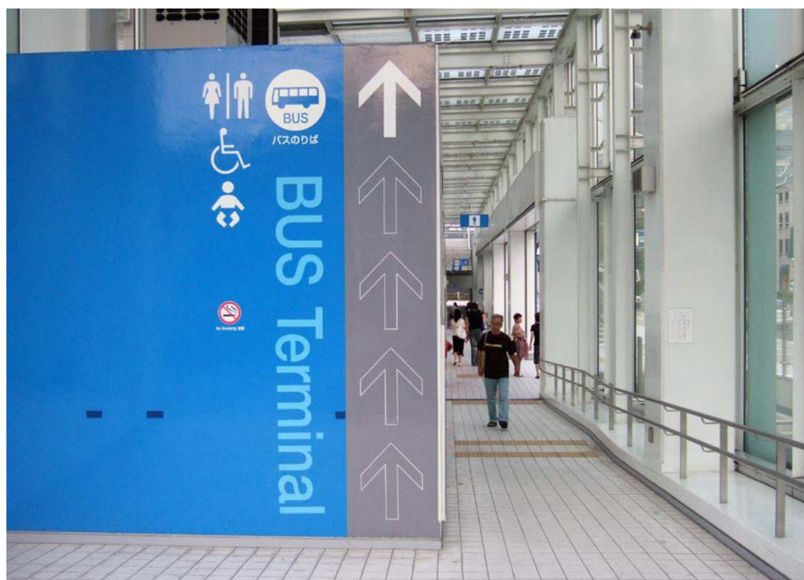
Figura 10.54 O oferecimento de banheiros de boa qualidade no terminal central de ônibus em Nagoya atende muito bem às necessidades dos usuários.
