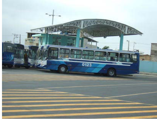
Figuras 11.120 e 11.121 A arquitetura para as áreas de manutenção tanto em Bogotá (foto esquerda) quanto em Guayaquil (foto direita) é tanto esteticamente agradável quanto altamente funcional.
