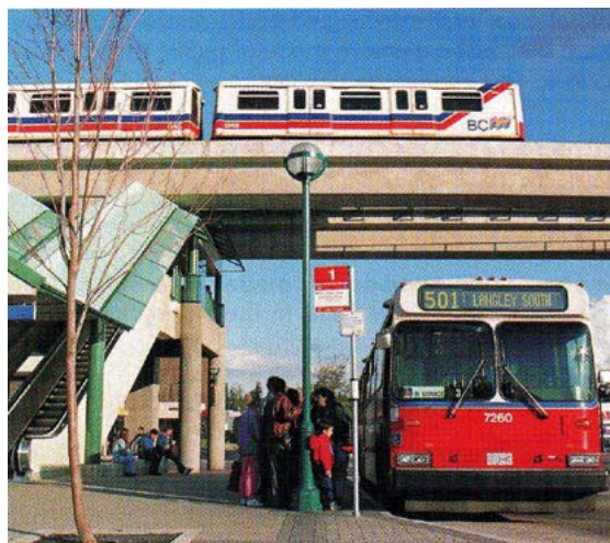
Figura 2.51 Sempre que há uma diferença de nível (de superfície) entre serviços de transportes públicos, haverá desafios para facilitar as transferências simples, especialmente para pessoas com deficiências físicas.
