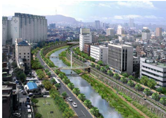
Figuras 14.16 e 14.17 Imagens de antes e depois do projeto do corredor Cheonggyecheon em Seul. Apesar de por abaixo uma das principais vias expressas para a cidade, os impactos resultantes de congestionamento foram mínimos, especialmente uma vez que novos corredores de BRT receberam viagens de outrora usuários de carros.
