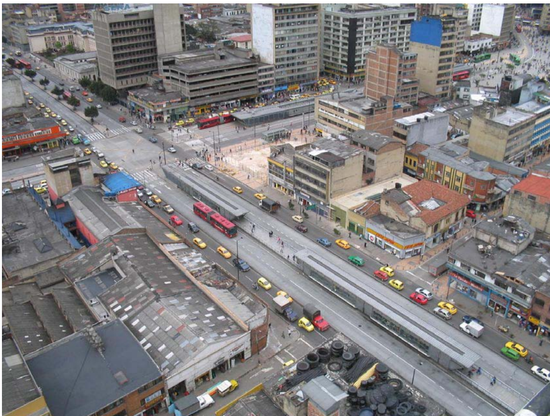
Figura 8.5 O uso de múltiplas baias de parada e faixas de ultrapassagem em Bogotá ajudam a minimizar o congestionamento de ônibus.
