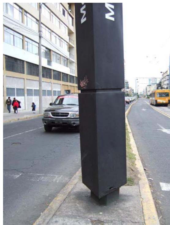
Figura 13.61 Este poste de identificação do BRT em Quito é posicionado em uma ilha de pedestres e age para bloquear a vista de pedestres tanto de veículos no tráfego misto, quanto de veículos de BRT se aproximando.
