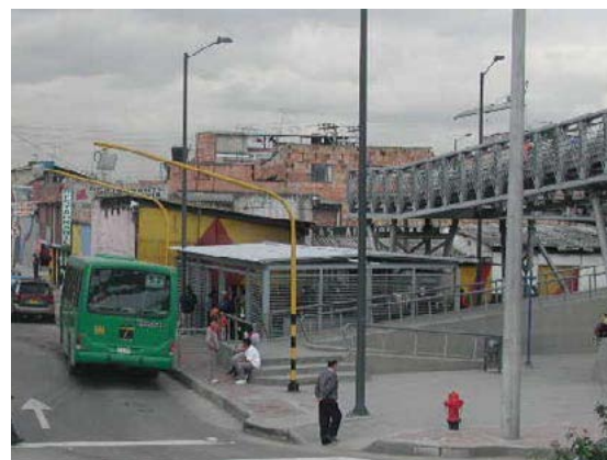
Figuras 11.82 e 11.83 Usuários chegando aos veículos alimentadores verdes em Bogotá fazem a transferência por uma passarela para entrar no serviço troncal.
