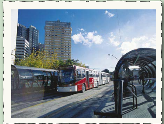
Capacidade e velocidade do sistema
