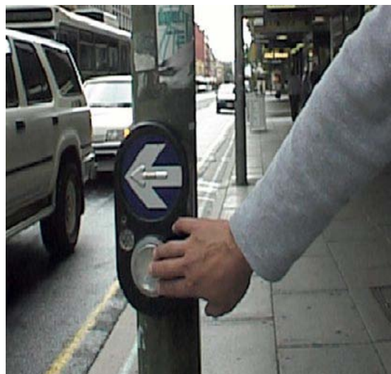
Figura 13.85 Uma botoeira tátil-vibratória para solicitação de uma fase de verde.
