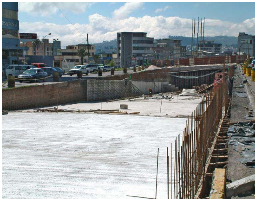
Figura 20.32 O redirecionamento de tráfego em volta de interseções sob construção pesada pode ser particularmente desafiador.
