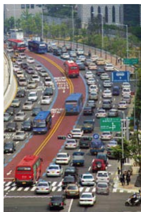
Figura 9 Corredor de ônibus segregado no canteiro central em Seul.
