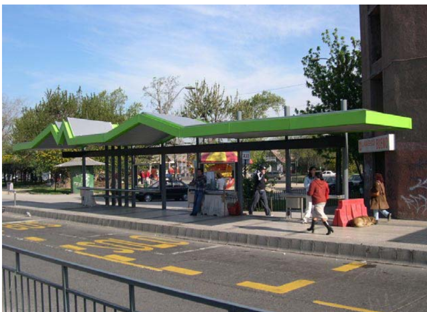
Figura 3.19 O projeto de estações e infra-estrutura mais básicos utilizados em Transantiago reduziu os custos e fizeram o sistema mais compatível com as operações de ônibus convencionais da cidade.
