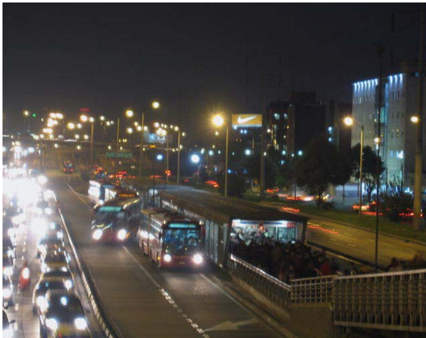
Figura 2.41 A existência de múltiplas baias de parada e faixas de ultrapassagem nas estações permitem que o sistema TransMilenio de Bogotá consiga atingir elevada capacidade de passageiros.
