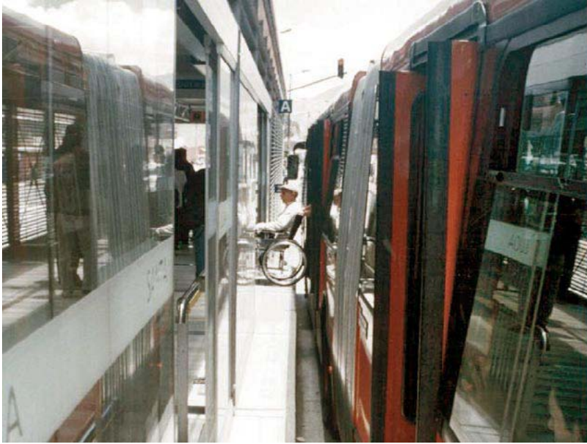
Figura 13.75 Em cidades como Bogotá, o embarque de plataforma em nível em corredores troncais tornam o embarque e desembarque fáceis para pessoas em cadeiras de roda.
