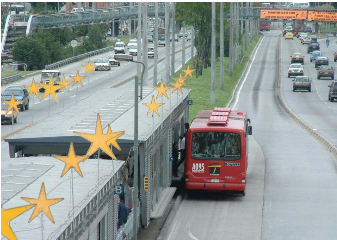
Figura 11.41 Em muitas estações dentro do sistema TransMilenio de Bogotá, uma área de transição existe entre uma via de ônibus de uma única faixa e a configuração de duas faixas para ultrapassagem.
