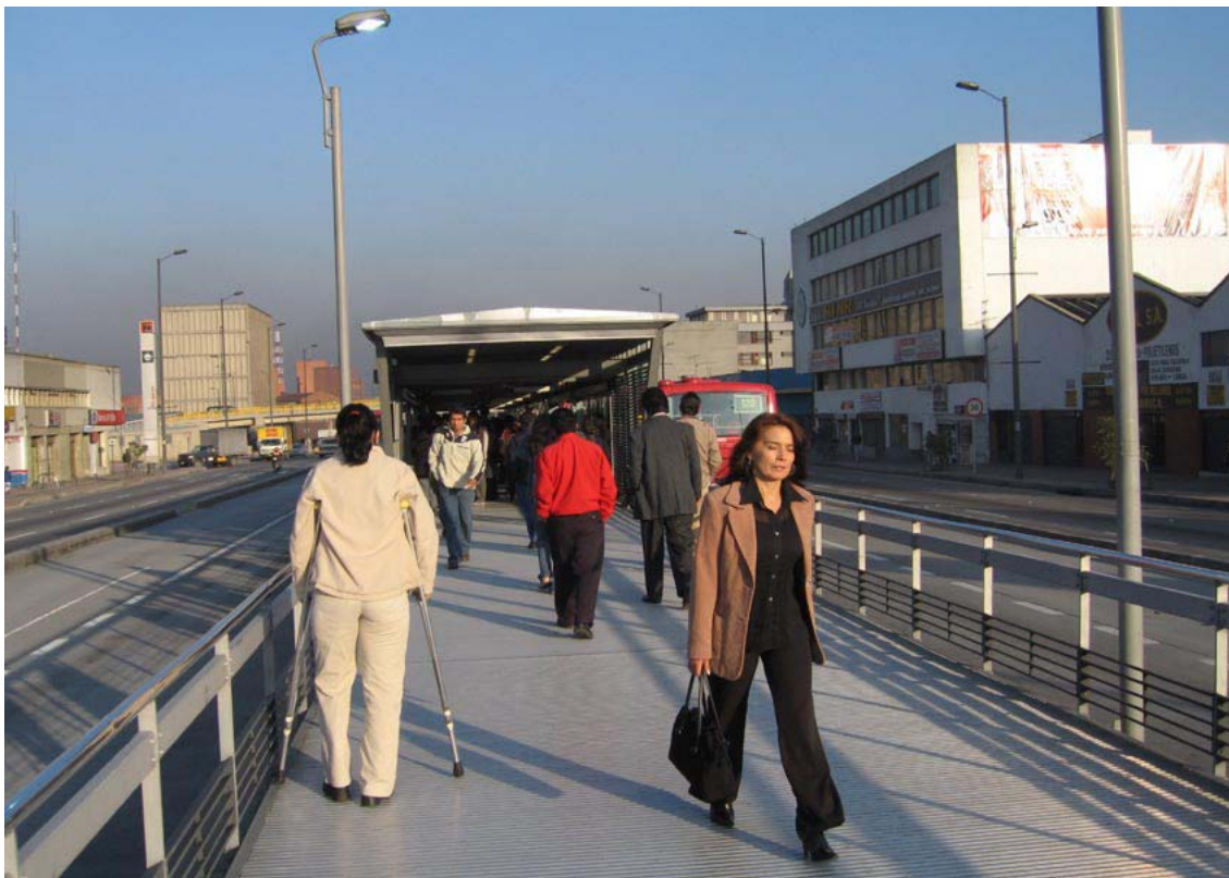
Figura 13.72 Pisos de estações e plataformas de transferência nivelados, em Bogotá facilitam a mobilização de qualquer pessoa de uma linha para outra.
