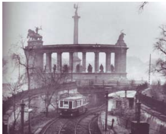
Figura 8 – Metrô de Budapeste
