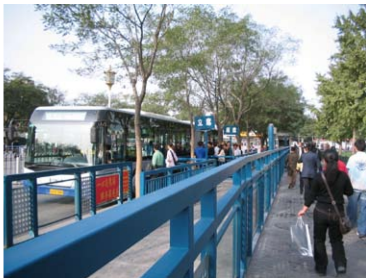
Figura 40 – Área de Espera do Ponto Final da Linha 1 do BRT de Beijing – Centro
