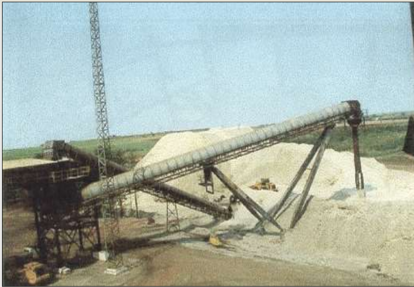
Vista do Sistema de bagaço
