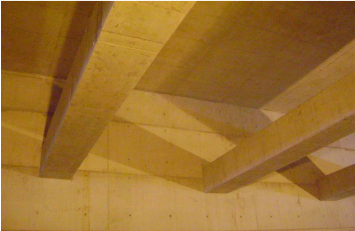
Figura 8 – Pergolado constituído por barras de concreto armado espaçadas que tem função de fornecer apoios horizontais para as paredes de uma galeria enterrada.
