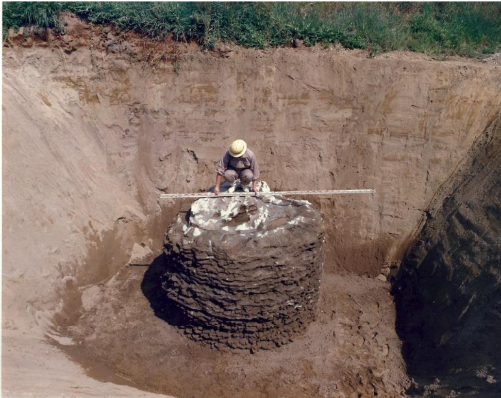
Figura 16 – Coluna de solo-cimento formada no solo com uso de “jet-grouting”.
