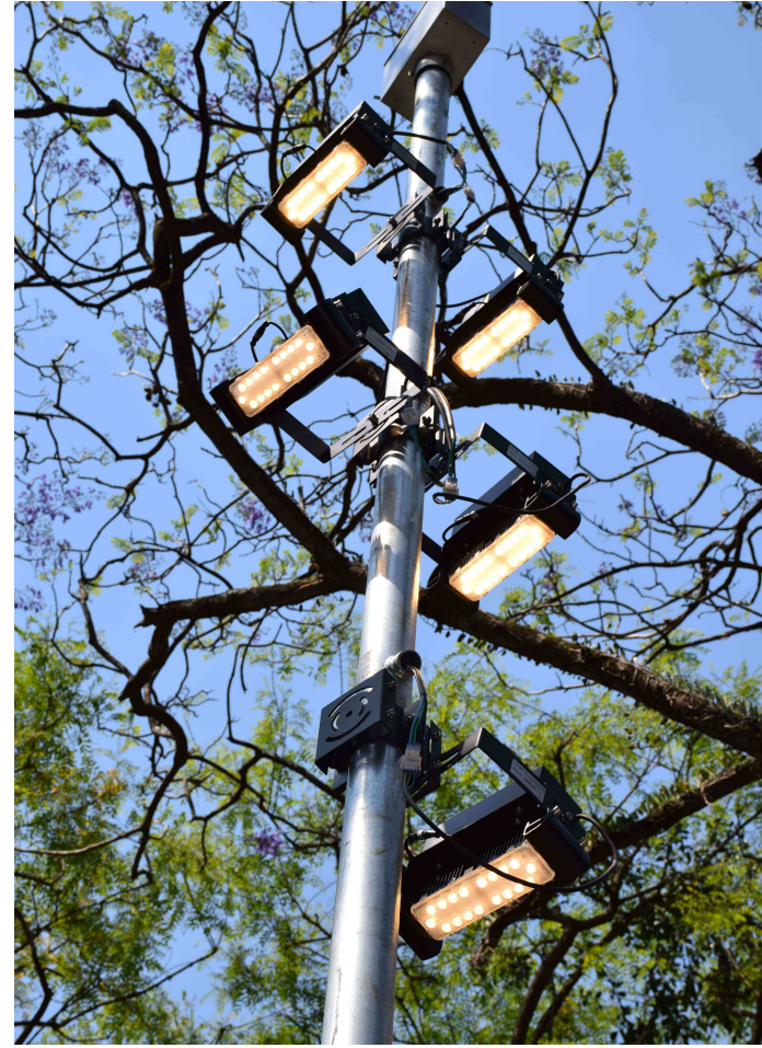
Lâmpadas de LED (eficiência – ~4 x) ↓
