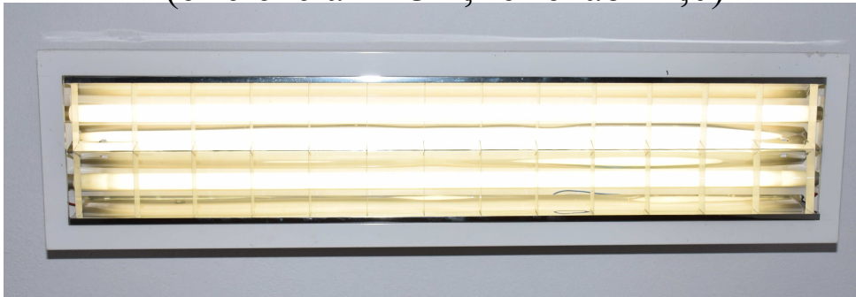
Lâmpada Fluorescente – Refletor Espelhado (eficiência – ~3 x, reflexão ~1,0)
