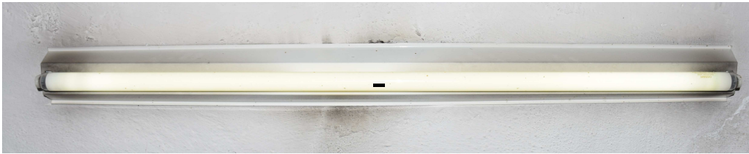
Lâmpada Fluorescente – Refletor Espelhado (eficiência – ~3 x, reflexão ~1,0)
