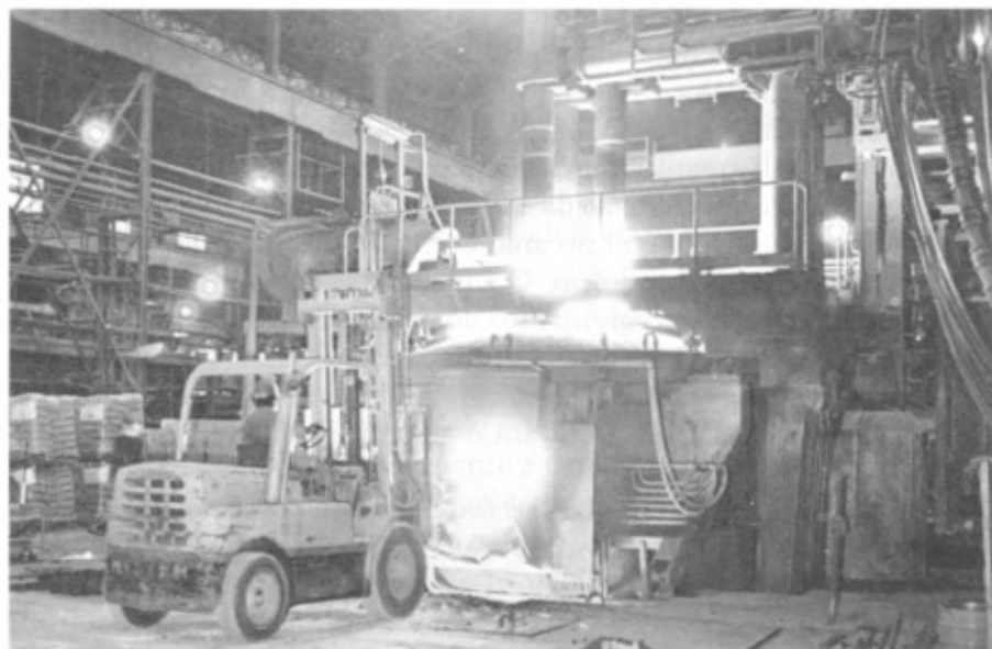
Fig. 8.8 - Forno elétrico a arco [vista pelo lado da porta].
