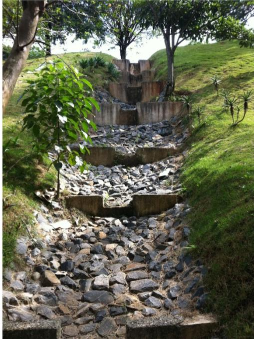
**Figura 20. Escada de dissipação com fundo empedrado e diques.**
