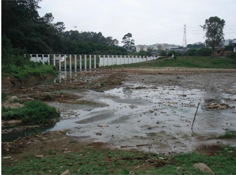
**Figura 13. Reservatório de detenção do Bananal visto de montante para jusante. Destaque da estrutura de gradeamento que serve como passarela improvisada a pedestres.**
