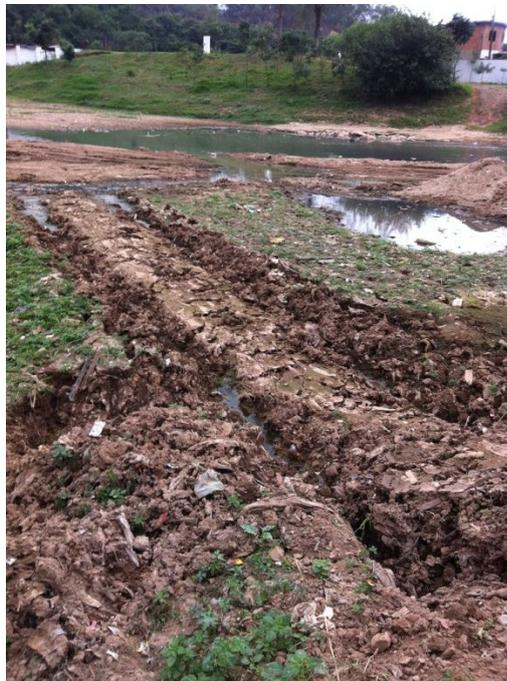
**Figura 14. Marcas de equipamentos de dragagem no reservatório de detenção do Bananal.**
