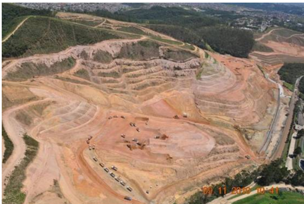
Figura A.1: Vista aérea da Cava Leste do Aterro CTL durante a fase de operação antes do início da fase de recebimento de resíduos. (fonte: PDD (Documento de Concepção de Projeto) do Projeto de Biogás de Aterro CTL, extraído do website da Convenção Quadro das Nações Unidas sobre Mudanças Climáticas (UNFCCC). [38])
