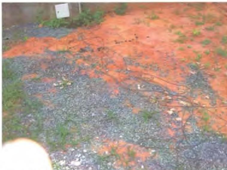
Foto 04- Nova fiação: fios soltos, emendados e sem proteção, dispostos no ambiente de trabalho.
