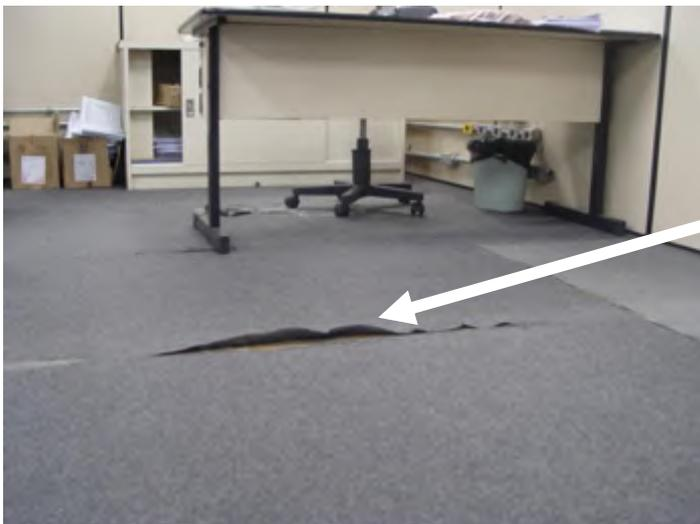
**Foto 09** – Visão geral do piso do ambiente de trabalho em Curitiba. Observem-se as péssimas condições do piso neste estabelecimento, que dificulta o trânsito acentuado de pessoas e movimentação de cargas no local, e criando fatores de risco de Acidentes de Trabalho por queda.
