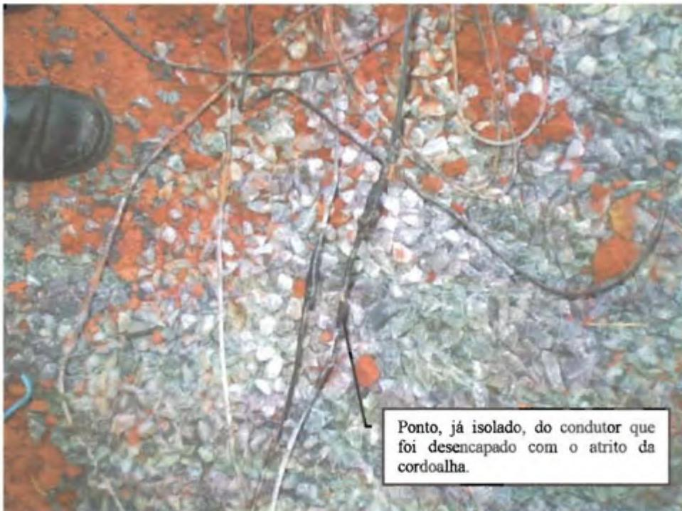
Foto 12-Detalhe dos fios elétricos desenterrados.
