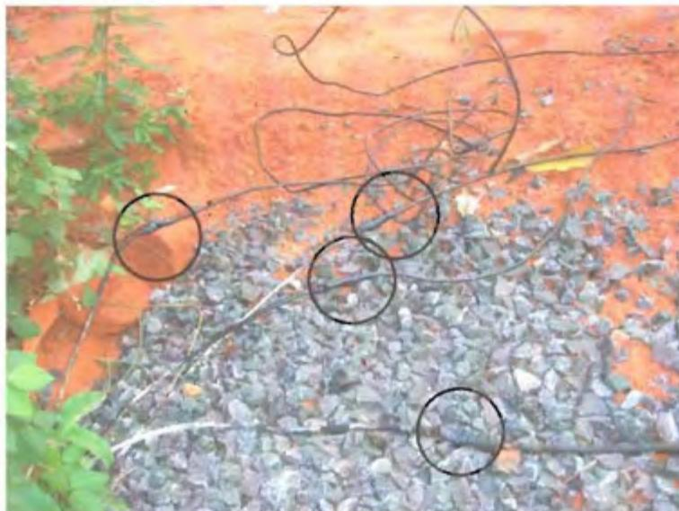
Foto 02- Detalhe dos quatro fios condutores emendados à fiação anterior.
