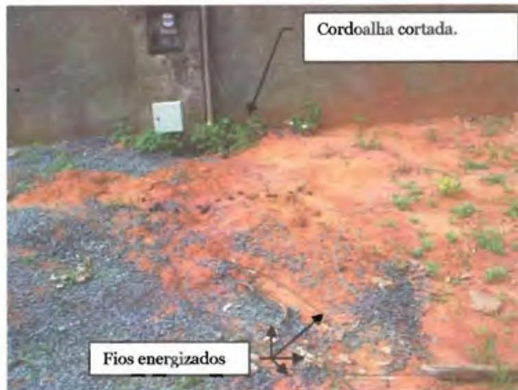
Foto 06-Cordoalha e fios elétricos energizados juntos no chão.
