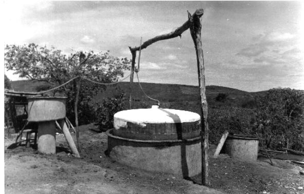
Figura 3 – Biodigestor modelo indiano construído em ferrocimento artesanal, com capacidade de produção de 10 m<sup>3</sup> de biogás/dia.
