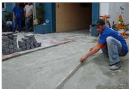
3 Espalhamento e nivelamento de areia de assentamento
