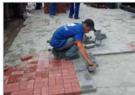
4 Colocação das peças, ajustes e compactação inicial
