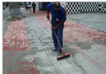
6 Limpeza e abertura ao tráfego
