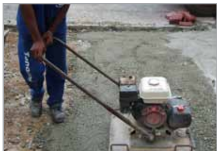
2 Montagem da base e contenções laterais
