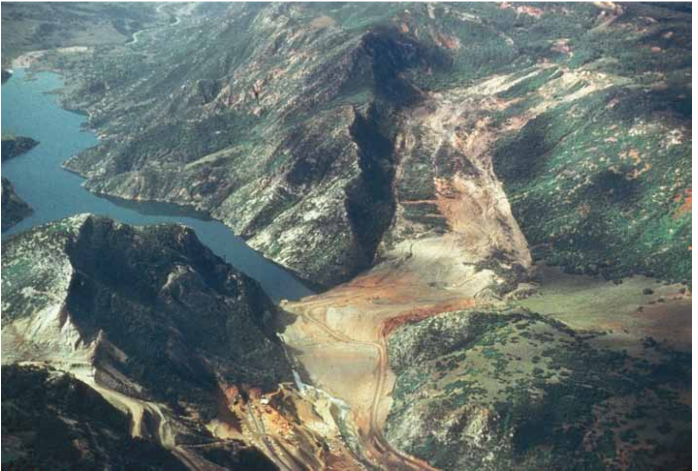
Figura C53. O deslizamento Thistle, em Utah, EUA, 1983. Este deslizamento represou um rio, que formou um lago (chamado de “Thistle Lake”) por trás da represa, inundando a cidade de Thistle. (Fotografia por Robert L. Schuster, US Geological Survey)
