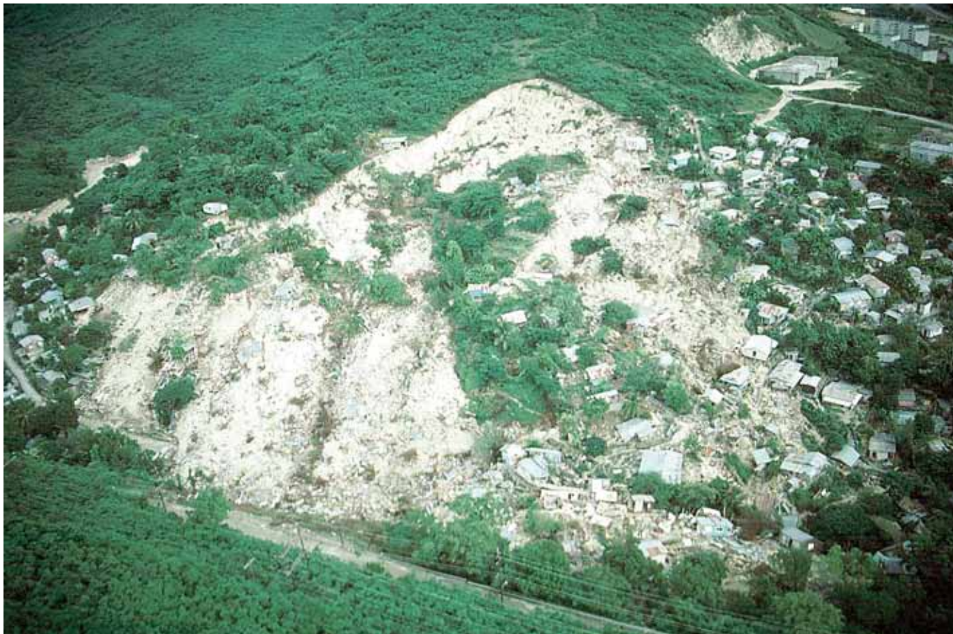
Figura 26. O Mameyes, Porto Rico, deslizamento de terra, 1985. Este deslizamento de terra destruiu 120 casas e matou pelo menos 129 pessoas. O fenômeno catastrófico foi provocado por uma tempestade tropical que produziu chuvas extremamente pesadas. Os fatores contribuintes também podem ter incluído saturação por esgoto em área densamente povoada, e canalização de água com vazamento bem no cume do deslizamento. (Foto de Randall Jibson, U.S. Geological Survey).
