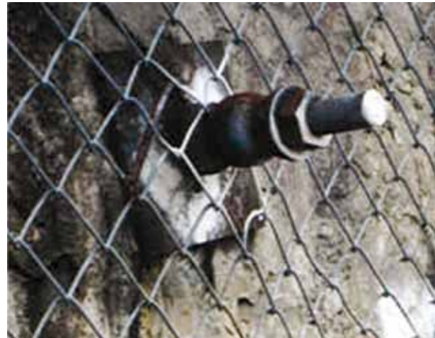
Figura C32. Fotografia em close de uma âncora em uma superfície de rocha, com malha sobre ela para maior proteção. A âncora é fincada na rocha a cerca de 5 metros (15 pés) de profundidade.
