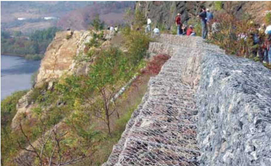
Figura C16. Desenho esquemático e fotografia de um muro de gabião ao longo de uma rodovia. (Esquema da Referência 11). (Fotografia de gabiões localizados nas montanhas de Pocono, Pensilvânia, EUA, por Lynn Highland, U.S. Geological Survey).
