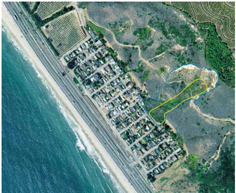
Figura B4. Um exemplo de uma fotografia aérea do deslizamento La Conchita, na Califórnia, EUA, tirada em 2005. A linha azul delinea um deslizamento mais antigo e a amarela, um deslizamento mais recente. (Foto cedida por AirPhoto USA e Condado de Ventura, Califórnia, e Randy Jibson, U.S. Geological Survey).
