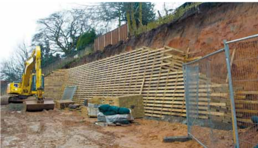
Figura C13. Desenho esquemático e fotografia de uma grade de madeira. (Esquema da Referência 11, fotografia é cortesia do PHI Group, Reino Unido).
