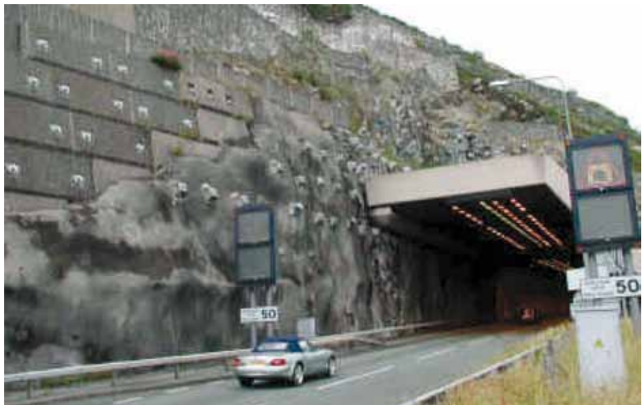
Figura C20. Esta fotografia mostra medidas contra quedas de rochas que incluem muros de contenção de concreto maciço, paredes de gabião (ambos os tipos de muro estão no topo da fotografia), cercas de seleção, tratamento de pedregulhos e pilares. (Foto é o túnel de Pen-y-Clip em uma rodovia no Norte do País de Gales, Reino Unido. Fotografia por Dave Giles, Grupo de Consultoria em Geologia de Engenharia, da Universidade de Portsmouth, Reino Unido).
