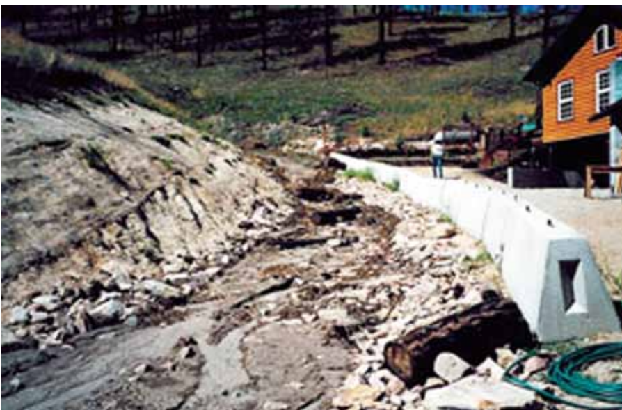
Figura C6. Exemplo de revestimento de canal com rochas, Dickson Creek, Montana, E.U.A (Fotografia e gráfico, U. S. Department of Agriculture).
