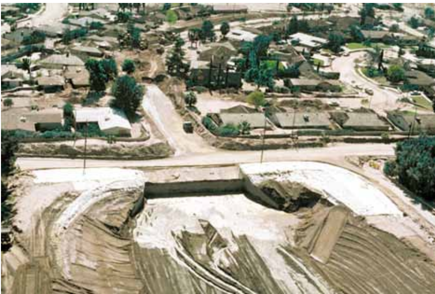
Figura C35. Fotografia aérea de uma bacia de fluxos de detritos, construída no fundo de uma encosta, em San Bernardino, Califórnia, EUA. (Fotografia por Doug Morton, US Geological Survey).
