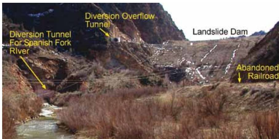
Figura C54. Vista em close das medidas de atenuação tomadas para reduzir o impacto da barragem de deslizamento Thistle, mostrando o túnel para o rio e o túnel para desvio da cheia. (Fotografia em cortesia do Utah Geological Survey)
