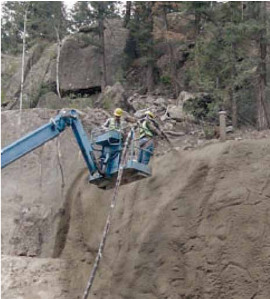
Figura C31. Operação com concreto projetado para estabilização de uma área de quedas de rochas em Wolf Creek Pass, Rocky Mountains, Colorado, EUA. (Fotografia do Departamento de Transportes do Colorado).
