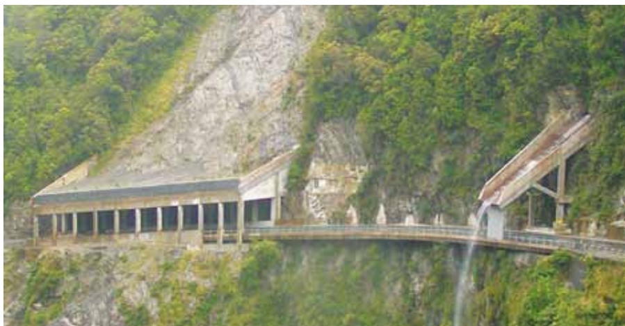
Figura C25. Exemplo de um galpão aberto, na Nova Zelândia (Foto por cortesia de Richard Wright, alpinista).
