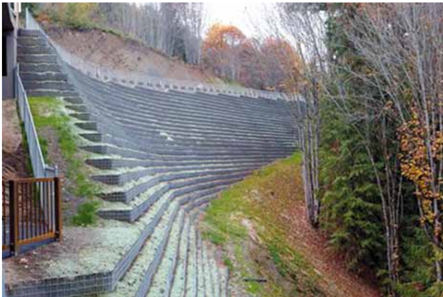
Figura C15. Desenho esquemático e fotografia de uma parede de terra-armada. (Esquema da Referência 11).
