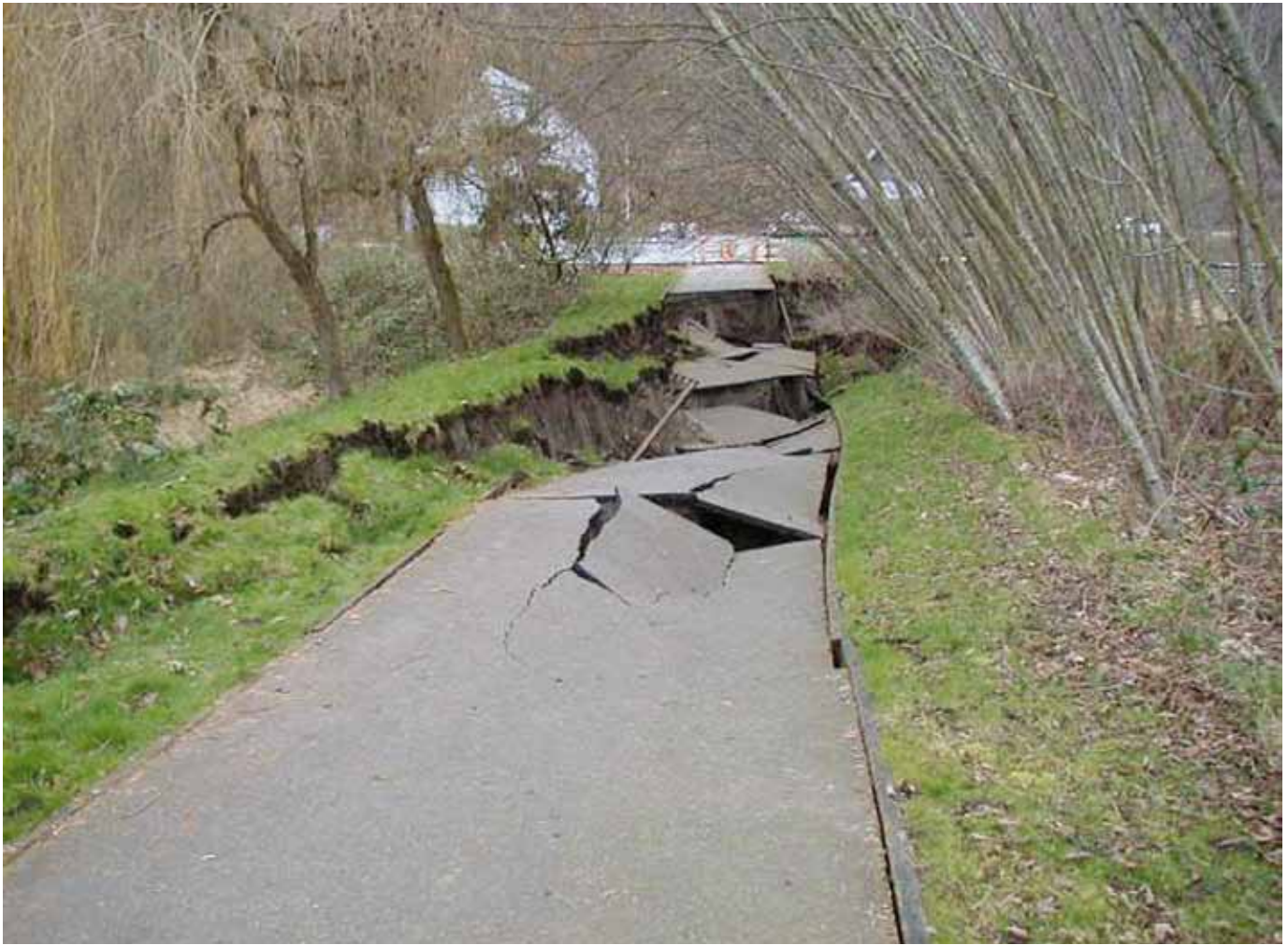
Figura 25. Danos de espalhamento lateral. A imagem mostra a área de Puget Sound em Washington, E.U.A, após o terremoto Nisqually, em 2001. (Fotografia por cortesia do Seattle Times).
