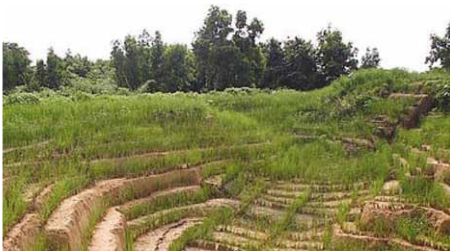
Figura C18. Um sistema de capim-vetiver vem sendo usado na República Democrática do Congo para o controle de voçorocas em áreas urbanas e para a estabilização da estrada. Esses sulcos (voçorocas) são um grande problema nesta área e em outros países do Oeste Africano (imagem ao alto); a mesma inclinação agora melhorou a drenagem, e a grama Vetiver foi plantada no talude (do meio), aqui o plantio de capim-vetiver tem cerca de 3 meses de idade (imagem inferior).
