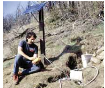
Figura B9. Teste de um sistema de radiotelemetria movido a energia solar para a transmissão remota em tempo real de dados do deslizamento. (Fotografia por Mark Reid, U.S. Geological Survey.)
