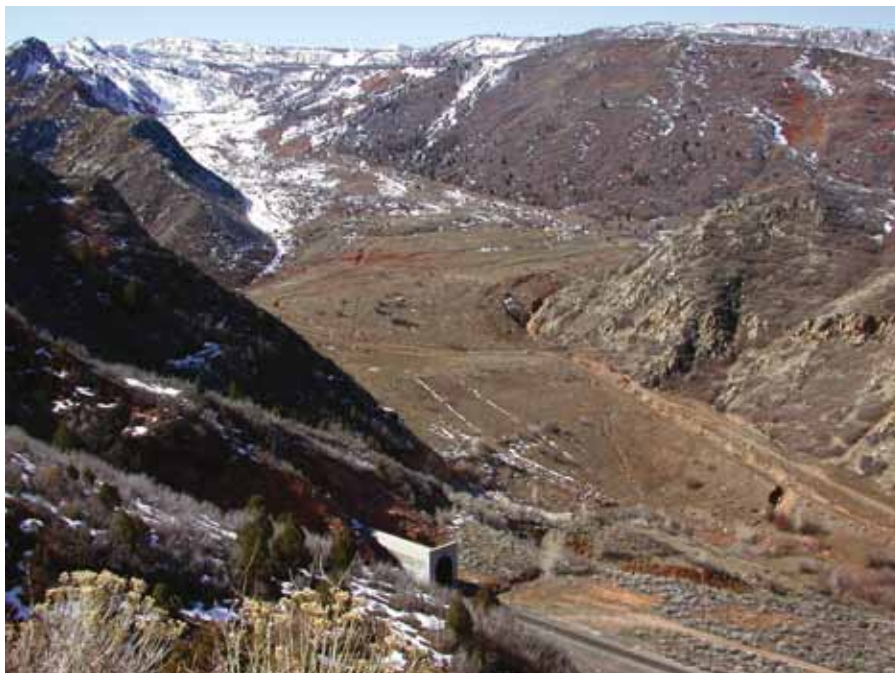
Figura 42. O deslizamento de terra Thistle no Utah, EUA. Este deslizamento de 1983 represou o rio Spanish Fork, represando a água que inundou a cidade de Thistle. Muitas barragens por deslizamento são bem menores que as mostradas aqui e, potencialmente, podem ser cobertas por água represada e sofrerem erosão. Algumas são muito maiores e estradas e ferrovias que são bloqueadas, ou danificadas, devem ser desviadas em torno da massa de terra. O túnel de concreto, na parte inferior da foto, mostra que a linha ferroviária foi desviada em torno do deslizamento tendo sido escavado por dentro de uma montanha adjacente.
