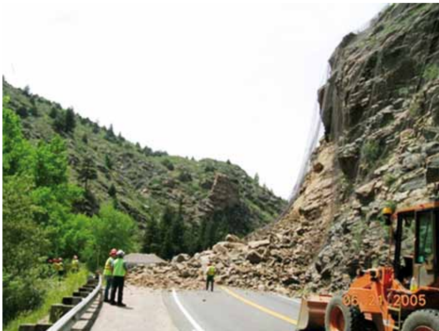
Figura 4. Queda rochosa e deslizamento ocorrido em Clear Creek Canyon, Colorado, EUA, em 2005, fechando o trânsito no canyon por várias semanas. A fotografia também mostra um exemplo de uma parede de pedras (cortina), um tipo de barreira comumente aplicado sobre faces rochosas de risco (centro e direita da foto). (Foto por Colorado Geological Survey).
