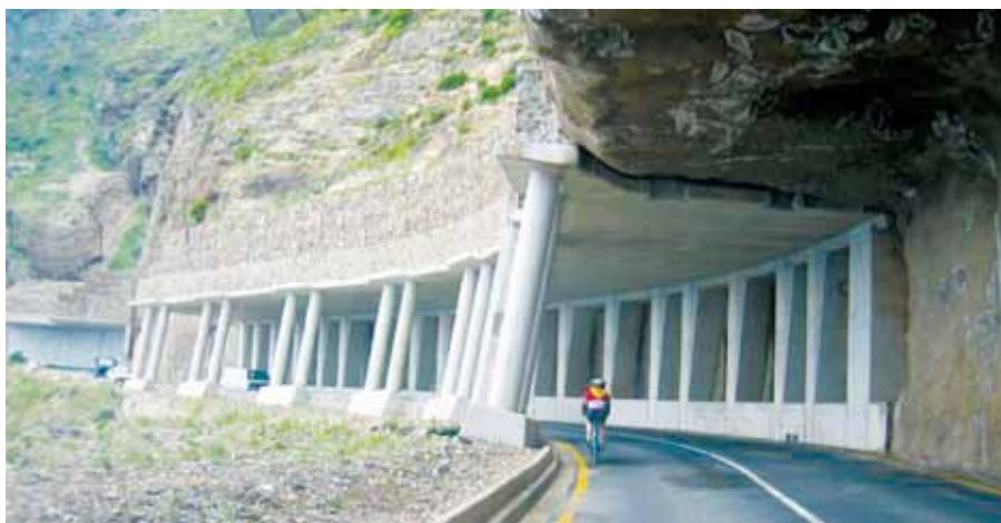
Figura C27. Exemplo de um rebordo reforçado, Chapmans Peak Drive, Cape Town, África do Sul. Fotografia: atribuição a http://commons.wikimedia.org/wiki/Image:Chapmans_peak_dr.jpg .
