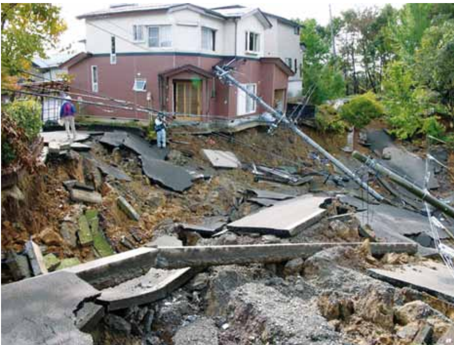
Figura 27. Danos de deslizamento induzido por terremoto a uma casa construída sobre aterro artificial, após o terremoto de 2004, na Prefeitura de Niigata, Japão. (Fotografia pelo Professor Kamai, Universidade de Quioto, Japão).
