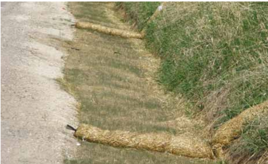
Figura C11. Feixes de palha na lateral de uma estrada capturam os sedimentos e os mantêm no local, permitindo, que sementes se estabeleçam e germinem, auxiliando o processo de revegetação. (Fotografia por Lynn Highland, U. S. Geological Survey)
