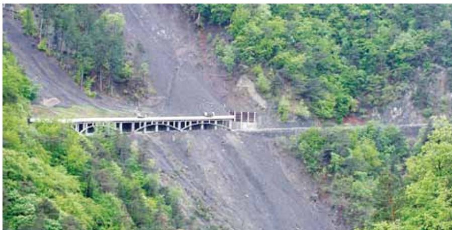
Figura C26. Um abrigo contra avalanche de rochas na área de Montenyard da França. O tamanho do abrigo parece ser insuficiente, pois um fluxo de detritos danificou a estrada, o que é mostrado à direita do abrigo. (Foto por Dave Giles, Group Consultoria de Geologia em Engenharia, da Universidade de Portsmouth, Reino Unido).
