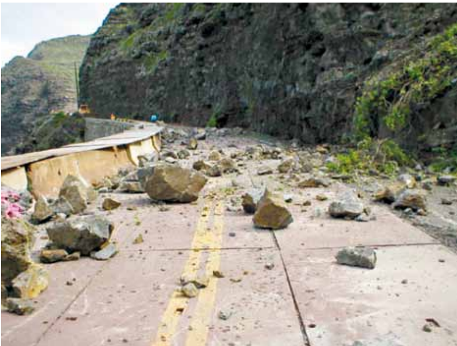
Figura C29. Rochas deslocadas pela tensão e explosão. (Fotografia do Departamento de Transportes de Washington, EUA)
