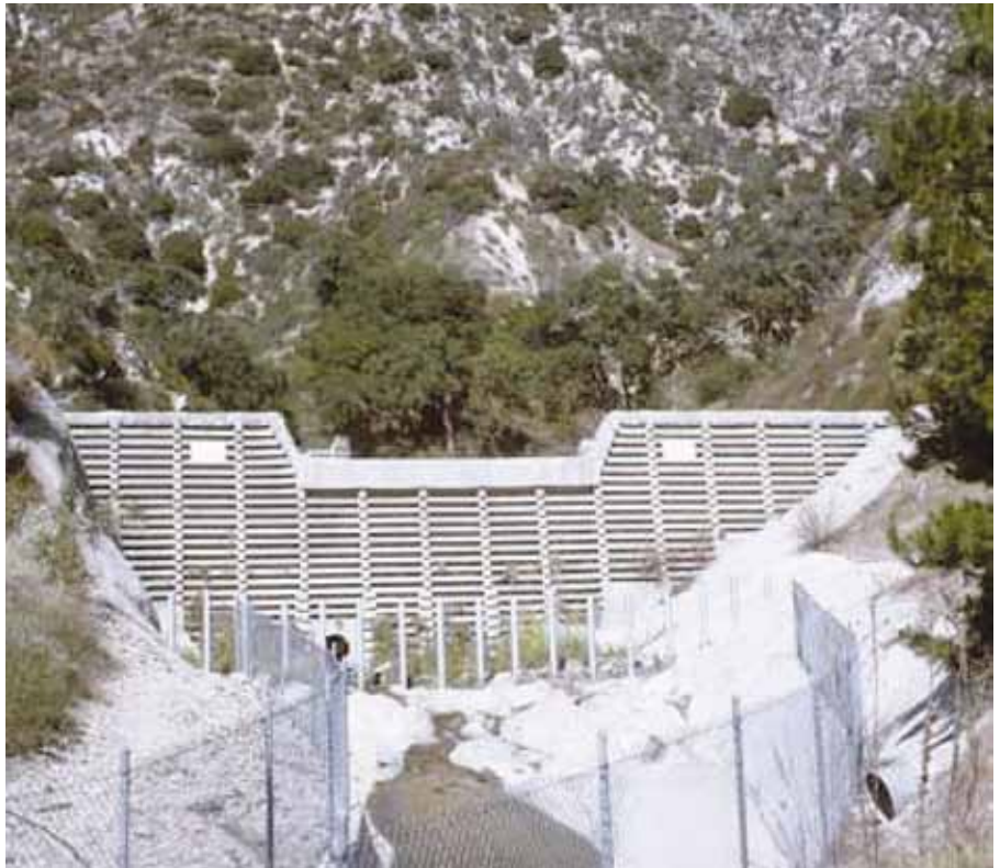
Figura C8. Vista da barragem de controle de concreto à montante, com seção central de baixo fluxo, no sul da Califórnia, EUA. (Fotografia por Controle de Inundações de Los Angeles County District.)
