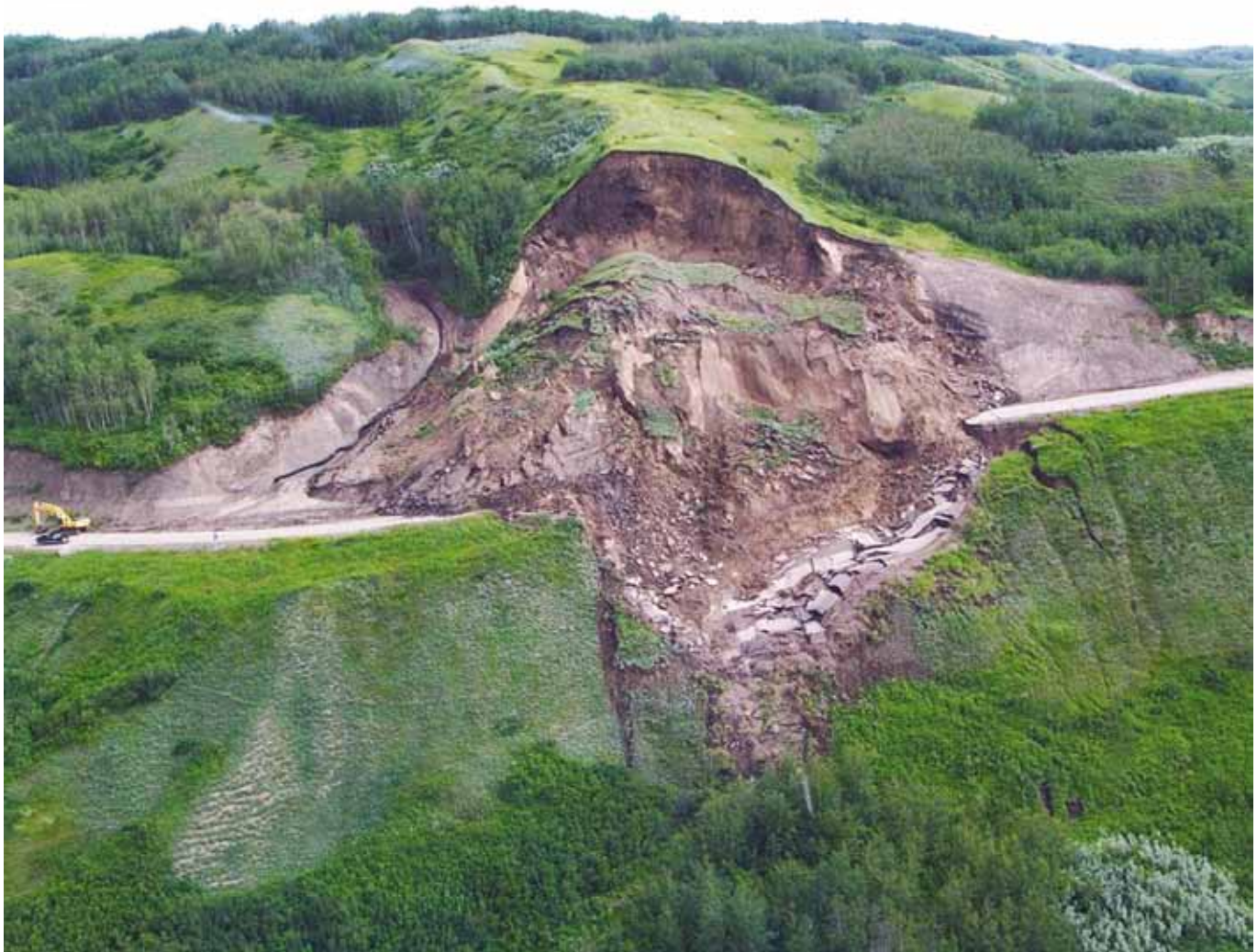
Figura 10. Imagem de um escorregamento translacional que ocorreu em 2001 no Vale do Rio Beatton, British Columbia, Canada. (Fotografia por Réjean Couture, Canada Geological Survey).
