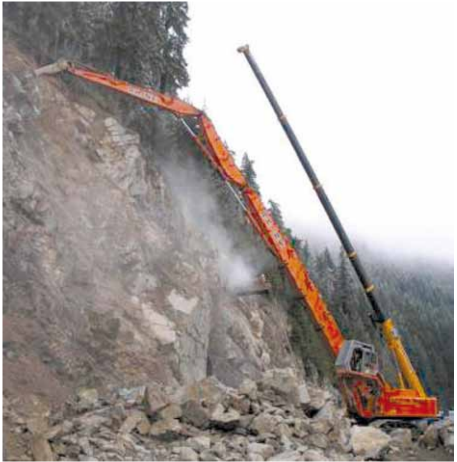
Figura C30. Martelo hidráulico (britadeira) em ação, derrubando rocha da encosta. Esta é uma alternativa para por rochas abaixo. (Fotografia do Departamento de Transportes de Washington, EUA).
