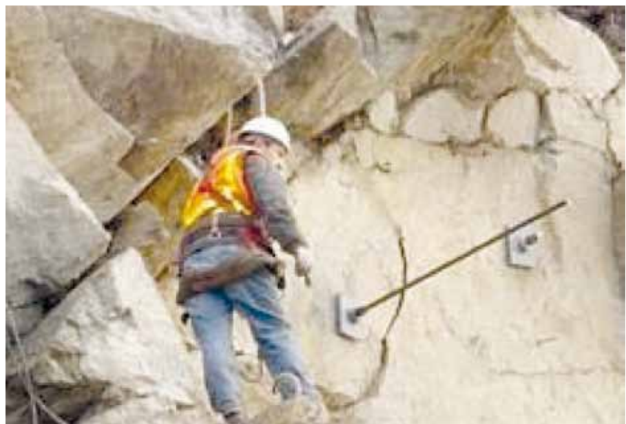
Figura C32. Fotografia em close de uma âncora em uma superfície de rocha, com malha sobre ela para maior proteção. A âncora é fincada na rocha a cerca de 5 metros (15 pés) de profundidade.
