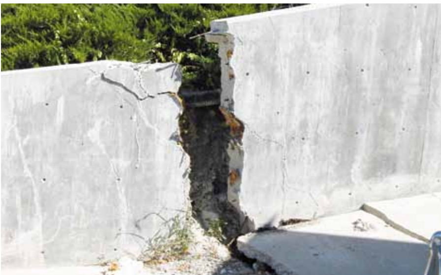
Figura 37. Calçada afastando-se da casa (Cortesia do Lynn Highland, U.S. Geological Survey).
