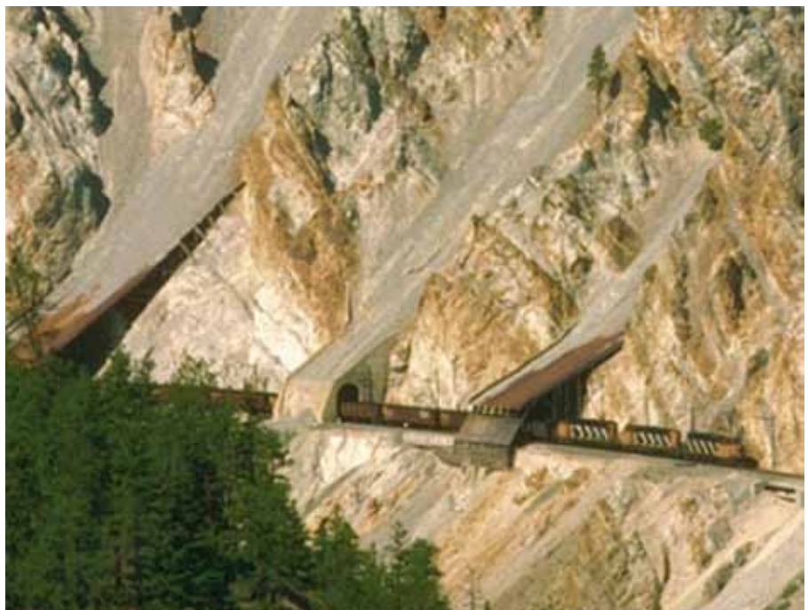
Figura C24. Galpões contra rochas em Pitquah, British Columbia, Canadá. Estes galpões cercam seções de uma estrada de ferro, protegendo-a contra quedas e avalanches de rocha. (Foto por John Carter, www.trainet.org ).
