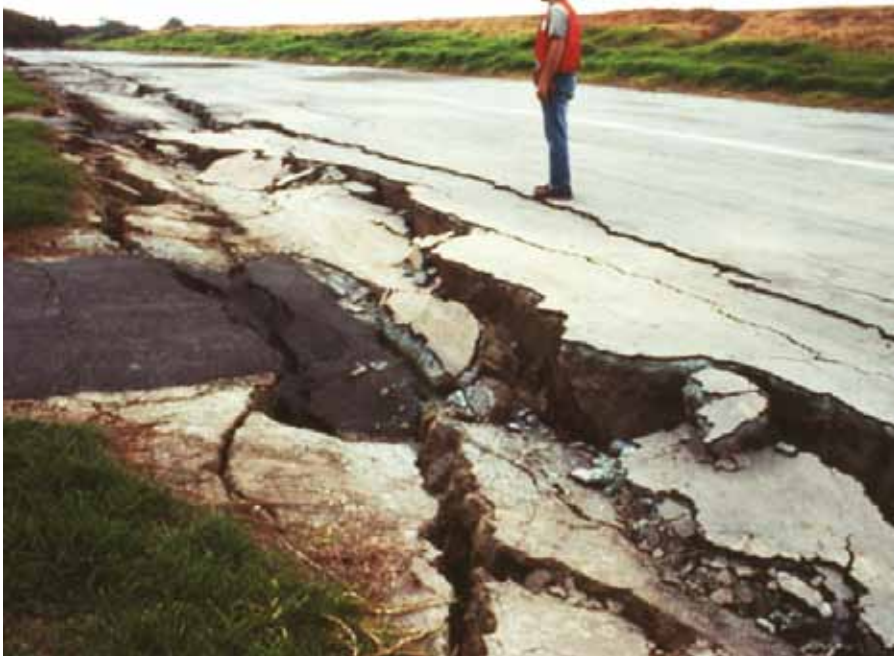
Figura 12. Fotografia de um espalhamento lateral ocorrido em uma rodovia, como resultado do terremoto Loma Prieta, em 1989, na Califórnia, EUA. (Fotografia por Steve Ellen, U.S. Geological Survey).
