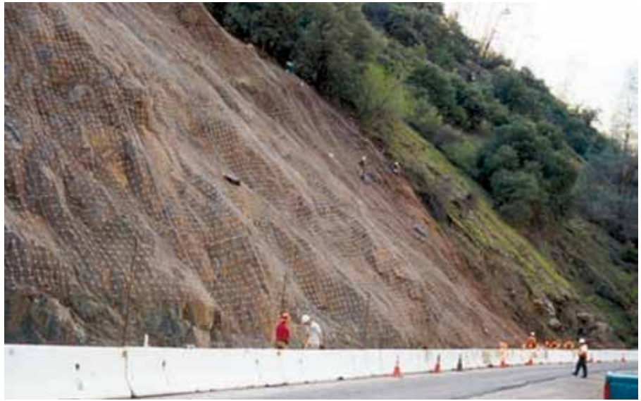
Figura C21. Exemplo de malha de arame colocada sobre uma encosta rochosa para conter as rochas que possam vir abaixo.
