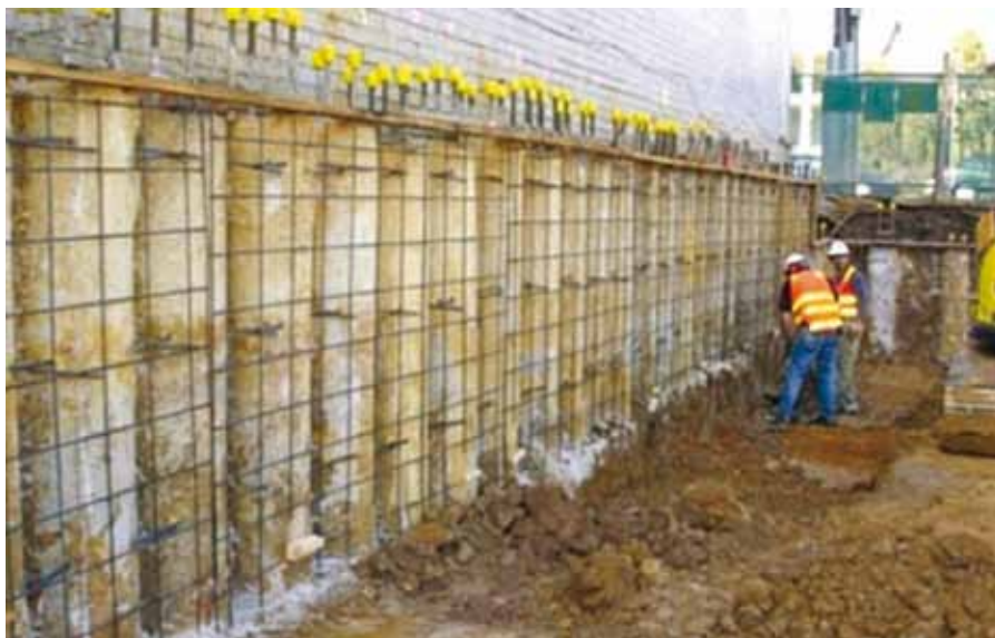
Figura C17. Uma parede de estaca preenchida por concreto. Uma rede de reforço foi colocada sobre a superfície das estacas, preparando-as para pulverização de concreto. A localização é Brighton, em Melbourne, Austrália. (Foto por cortesia de Basement Construction Services, Victoria, Austrália).
