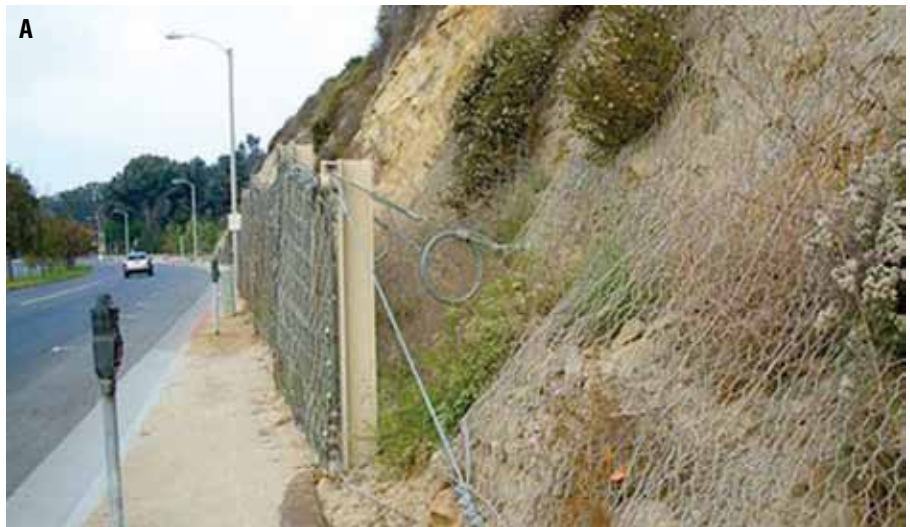
Figura C21. Exemplo de malha de arame colocada sobre uma encosta rochosa para conter as rochas que possam vir abaixo.
