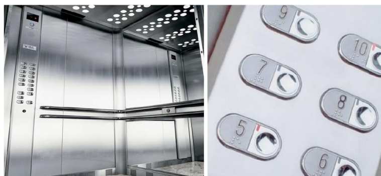
Figura 80. Elevador com painel de comando com código Braille, aviso visual e sonoro.
