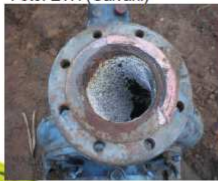
Desgaste em Válvula
