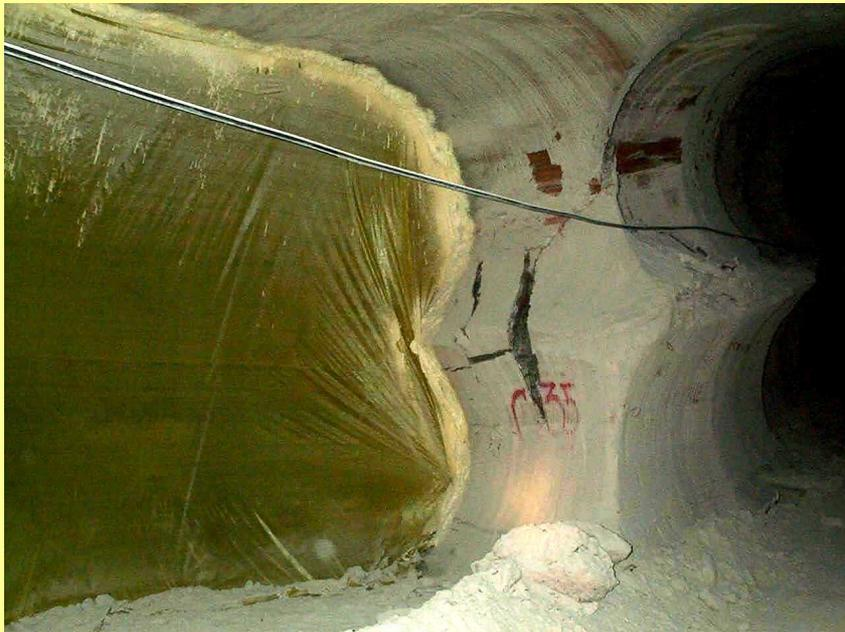
Foto de um pilar fraturado em Taquari Vassouras
