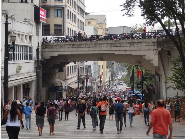
3) Viaduto Boa Vista
