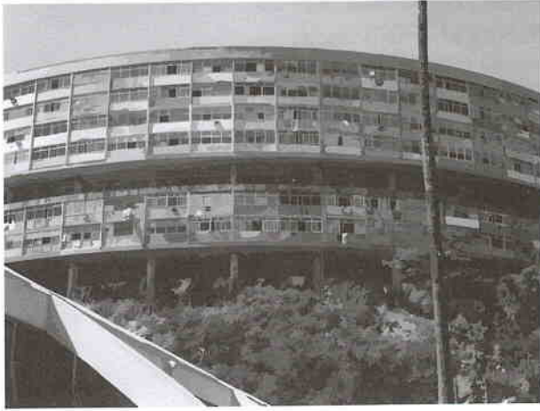
Fig. 1.9 Pavimento vazado no conjunto habitacional de Pedregulho (RJ)
