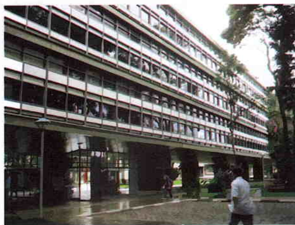
Fig. 1.8 Pilotis do edifício E1, São Carlos (SP) Foto: Leonardo Bittencourt.
