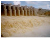
Produção de energia elétrica
