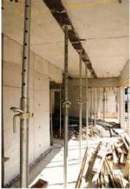
O plano operacional para o escoramento remanescente deve contar com projeto próprio, implicando diretamente nas propriedades do concreto. Os principais itens são o ciclo de concretagem, as características do concreto ao executar a laje imediatamente acima, a sobrecarga de utilização das lajes, o peso próprio, as características e o posicionamento das escoras e a quantidade de jogos necessários.
