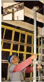
A parte inferior das fôrmas deve contar com marcas que determinem o posicionamento correto das escoras. A colocação das escoras deve ocorrer antes do lançamento do concreto. A tarefa deve ser executada pelo operário que acompanha a concretagem sob a laje.
