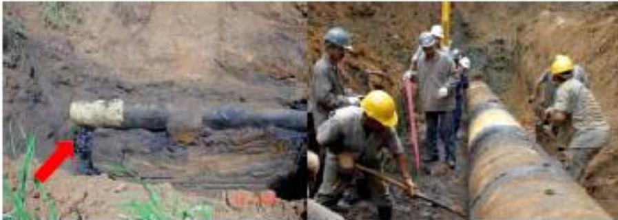
Fig. 9 - Ponto de vazamento identificado
