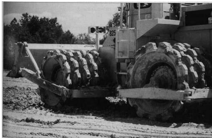
FIGURA 1.42 Compactação do solo usado em embasamento de estradas feito por equipamento pesado como rolos. (Foto cortesia de R. Weil)
