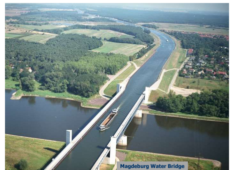
Liga o canal Elbe-Havel com o canal Mittelland. Trata-se do mais longo aqueduto do mundo (12 km). O baixo nível da água do Rio Elba impede a travessia da barcaça no canal.
