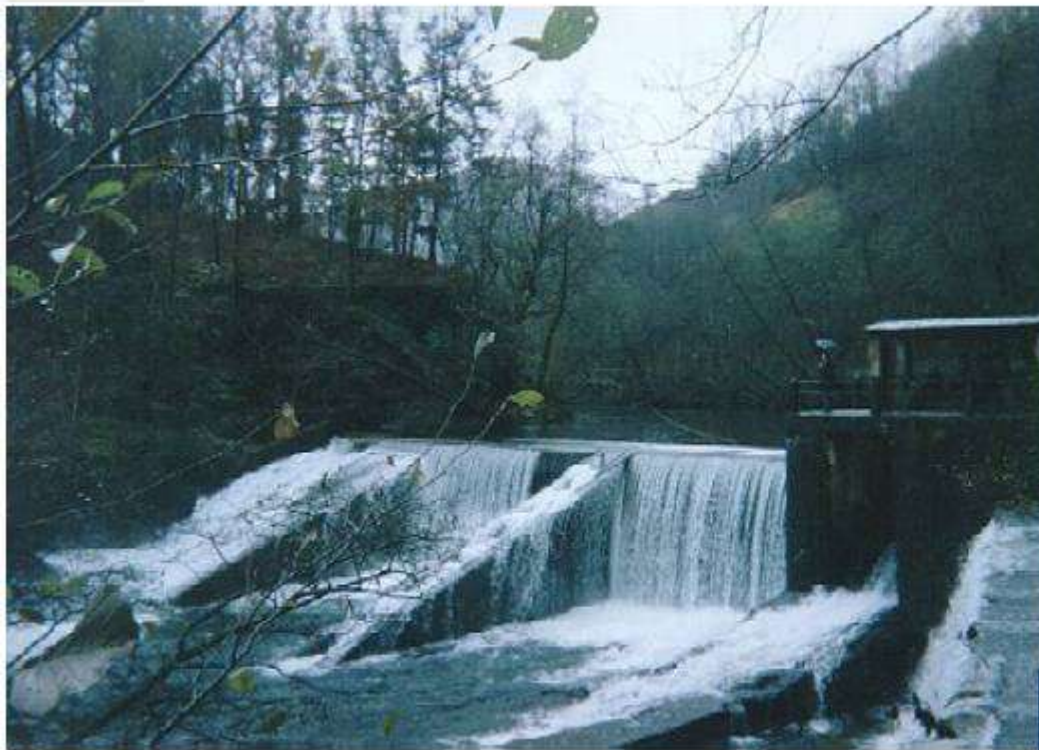
Queda de 89,23 m, vazão de projeto 6,75 \text{ m}^3/\text{s} turbinas Francis de 3 640 kW e 1 740 kW
