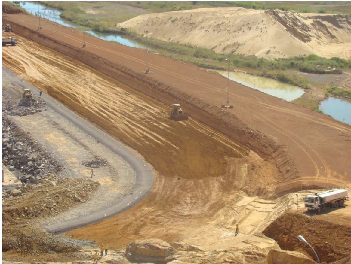
Foto: estradas de acesso na área da Barragem de Tucuruí
